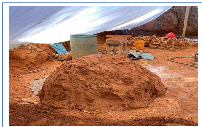
Figura 24. Mezcla lista para el moldeo
