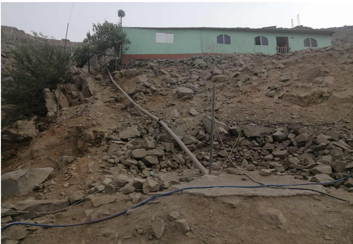
Figura 27: Descarga domiciliar a silo rustico
