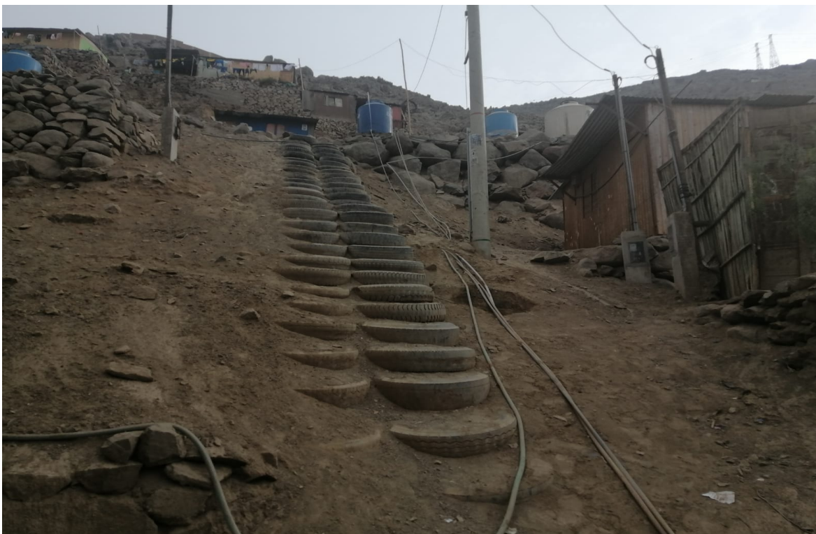
Figura 28: Escalera de acceso artesanal
