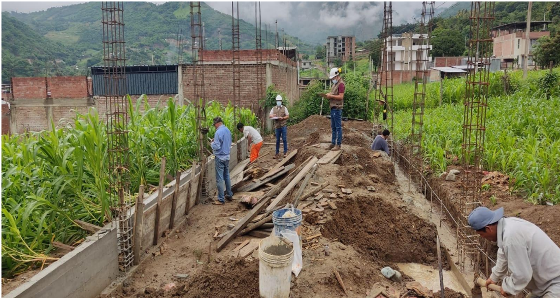
FOTO N° 02. Visita a la vivienda N°02, en etapa de construccion de sobrecimientos
