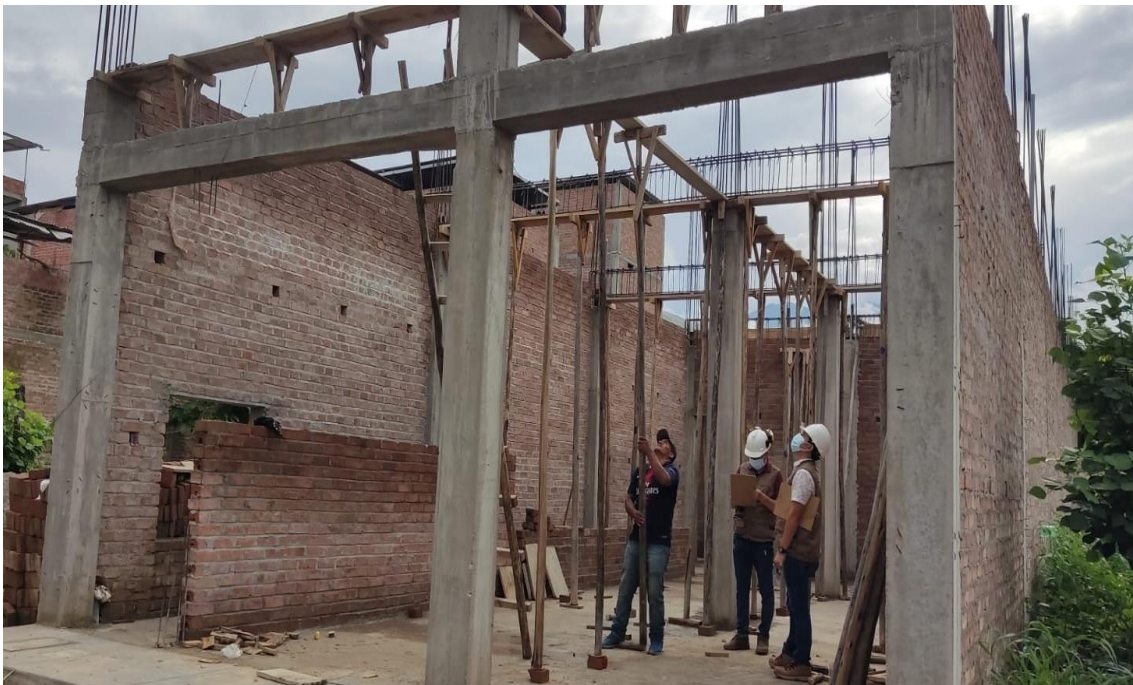
FOTO N° 10. Visita a la vivienda N°20, en etapa de encofrado de vigas principales.
