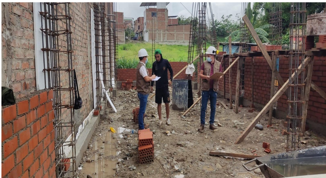
FOTO N° 04. Visita a la vivienda N°05, etapa de asentado de unidades de albañilería
