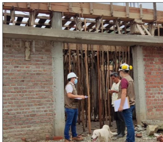
Figura 6. Encofrado de losa aligerada
