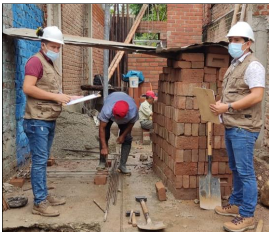
Figura 3. Habilitación de acero
