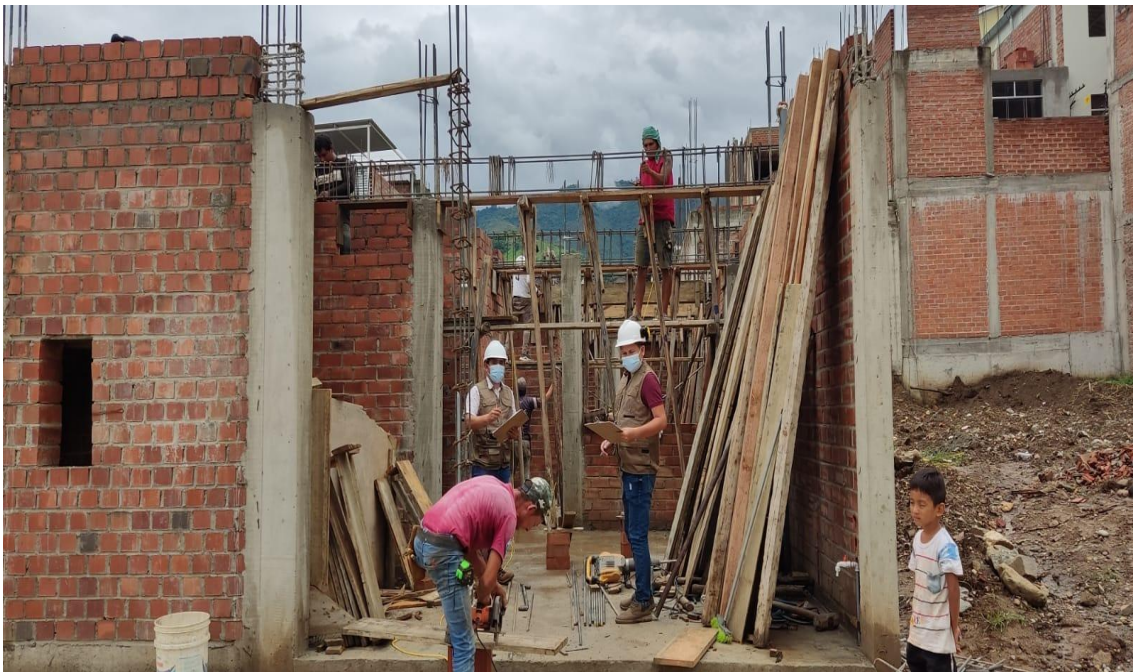
FOTO N° 12. Visita a la vivienda N°30, en etapa de encofrado de vigas.
