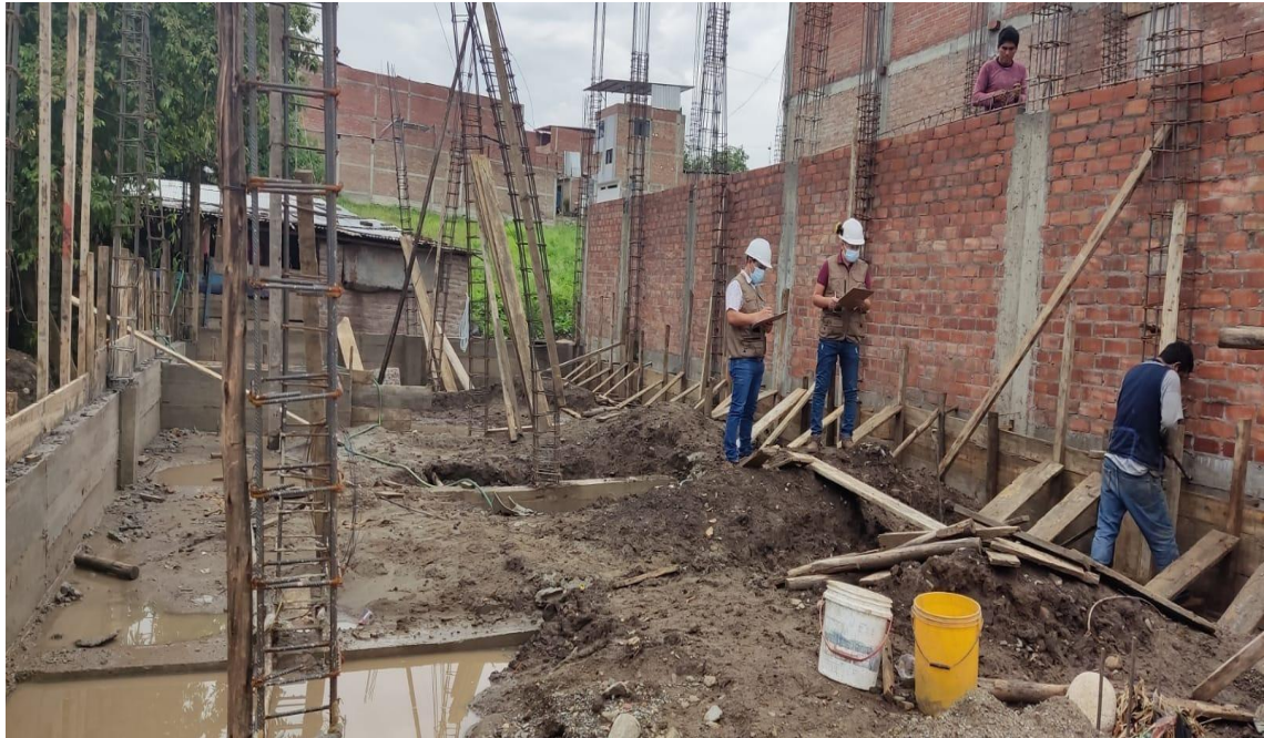
FOTO N° 03. Visita a vivienda N°03, en etapa de construcción de sobrecimientos.
