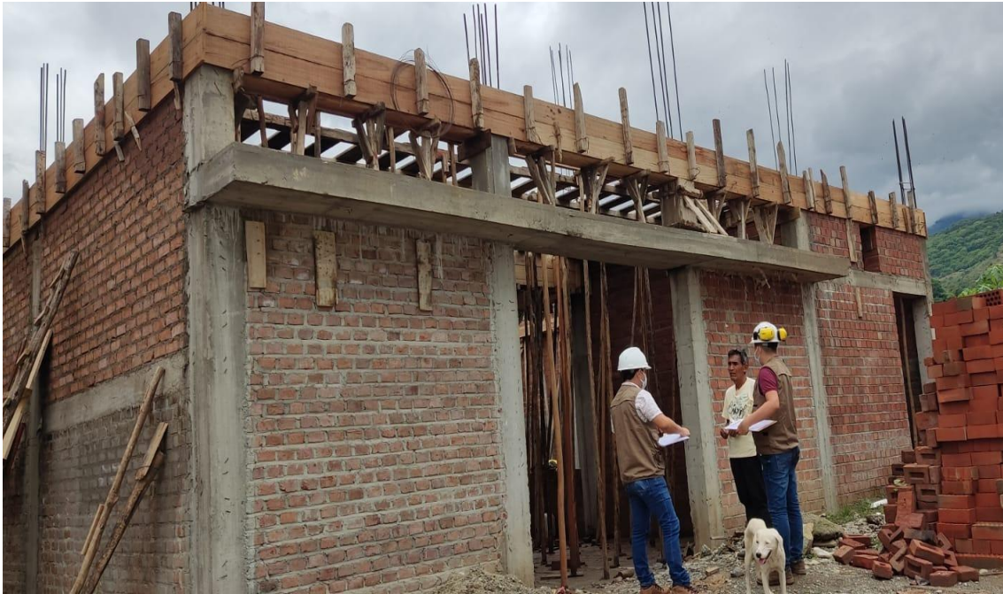
FOTO N° 11. Visita a la vivienda N°25, en etapa de encofrado de losa aligerada.
