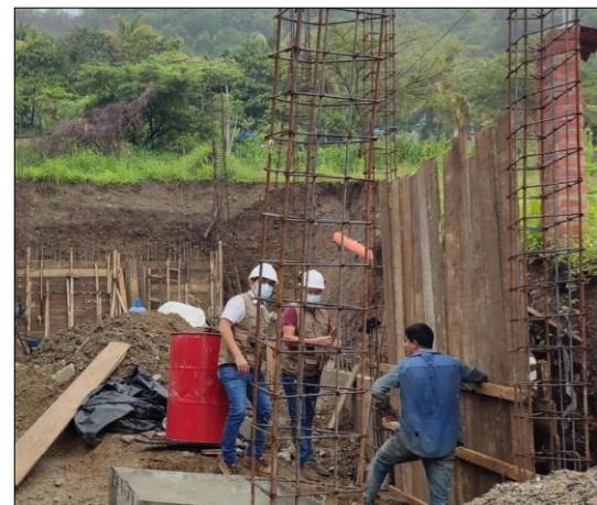
Figura 4. Encofrado de muro
