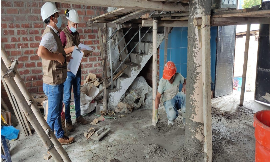
FOTO N° 05. Visita a la vivienda N°08, en etapa de acabados – tarrajeo.
