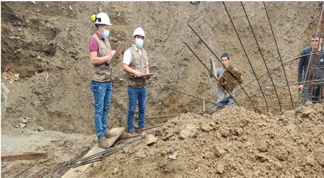
FOTO N° 06. Visita a la vivienda N°10, en etapa de construccion de cimentacion
