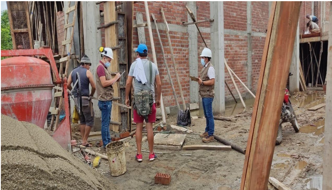
FOTO N° 08. Visita a la vivienda N°15, en etapa de encofrado de columnas.
