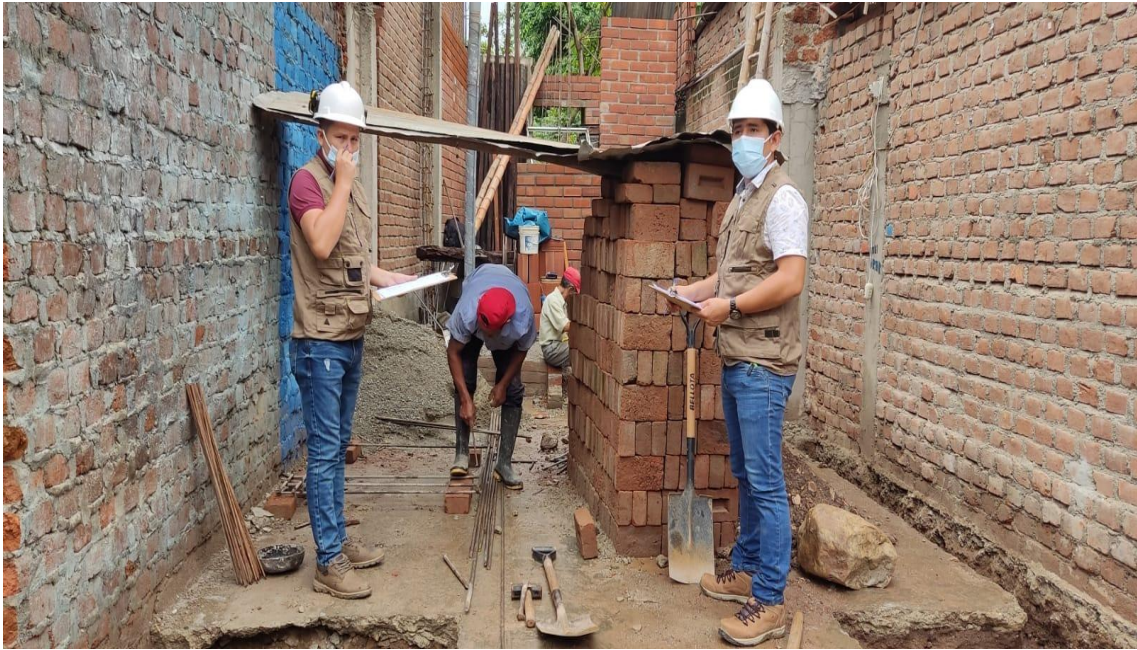
FOTO N° 01. Visita a la vivienda N°01, en etapa de excavacion para cimentacion
