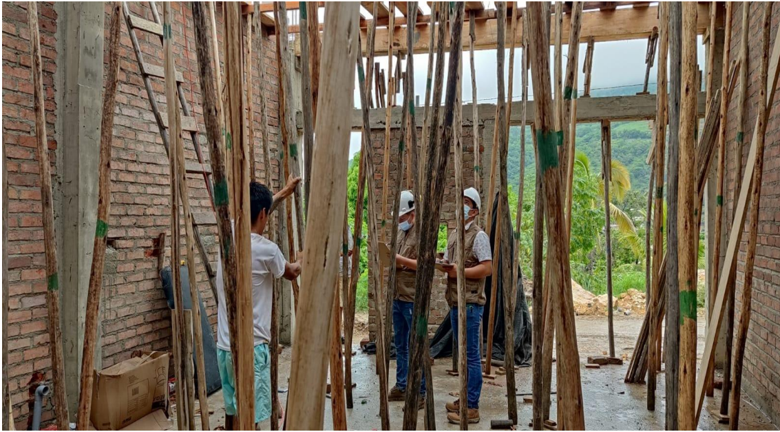
FOTO N° 07. Visita a la vivienda N°12, en etapa de encofrado de losa aligerada.
