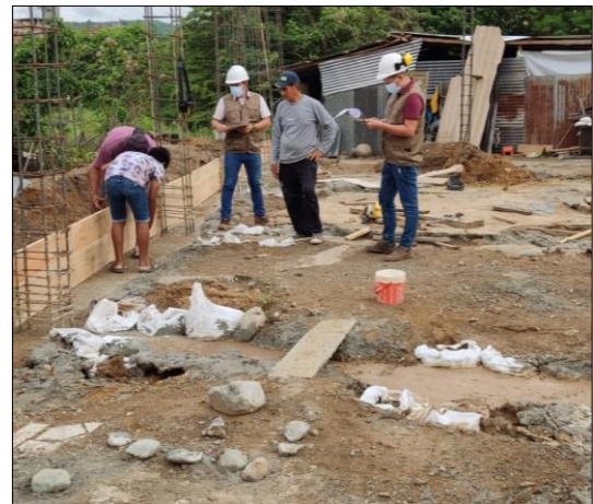
Figura 2. Encofrado de cimentación
