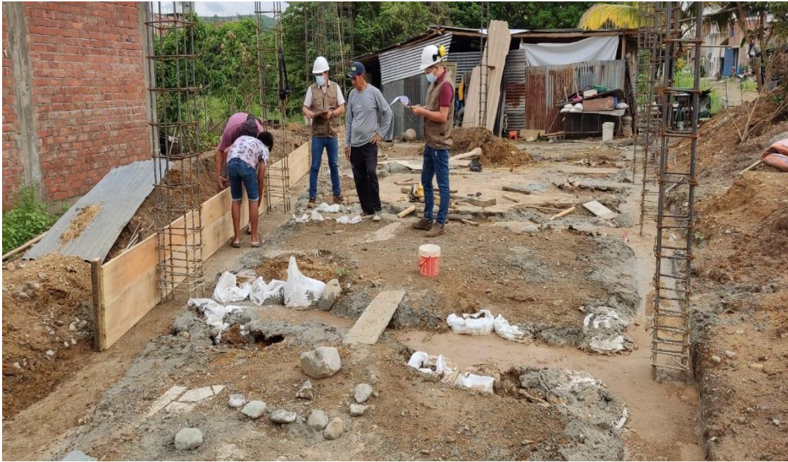
FOTO N° 09. Visita a la vivienda N°18, en etapa de encofrado de sobrecimientos.
