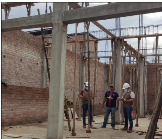
Figura 5. Encofrado de vigas de techo
