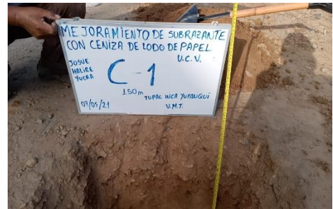
Imagen 4. Vista de datos calicata C-1
