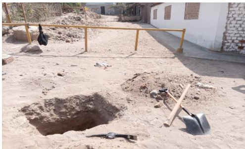
Imagen 3. Vista de la calicata C-2
