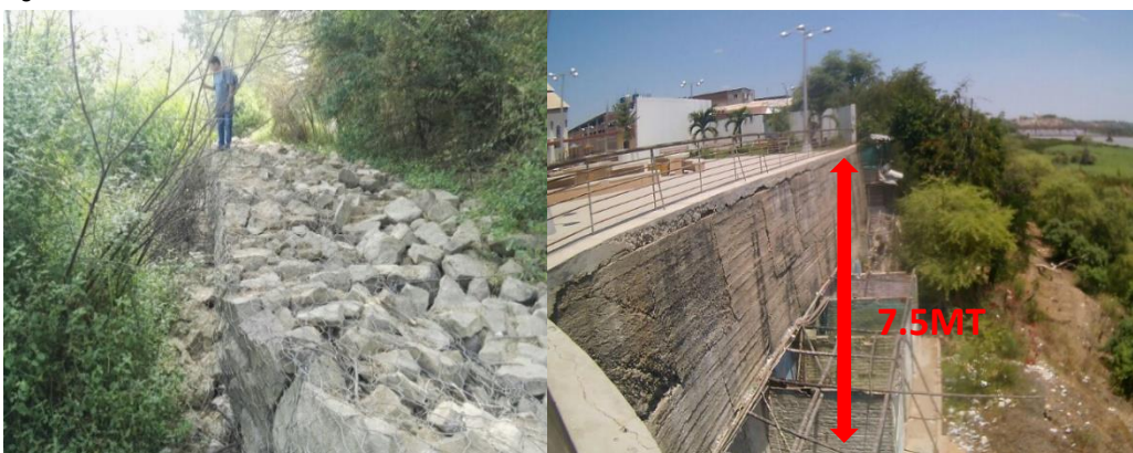
figura 29. Gaviones existentes
