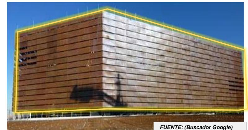
Se muestra que el auditorio presenta una cáscara envolvente de acero perforado y que tiene como característica que la corrosión no le afecte.
