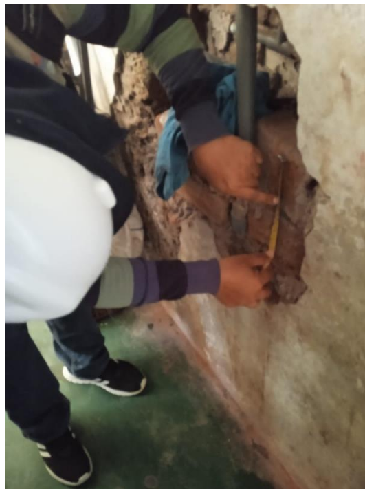
Anexo 7.6. Midiendo la separación de juntas de la vivienda 12 ubicada en la Mz. 21 Lt. 6.
