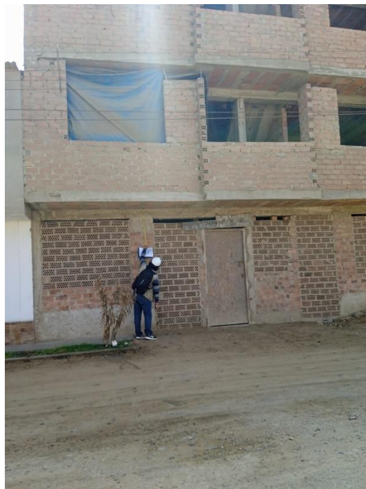
Anexo 7.8. Midiendo la altura del primer nivel de la vivienda 21 ubicada en la Mz. 37 Lt. 1.
