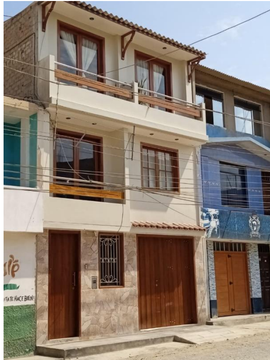
Anexo 7.3 Fachada de la vivienda 6 ubicada en la Mz. 29 Lt. 22.
