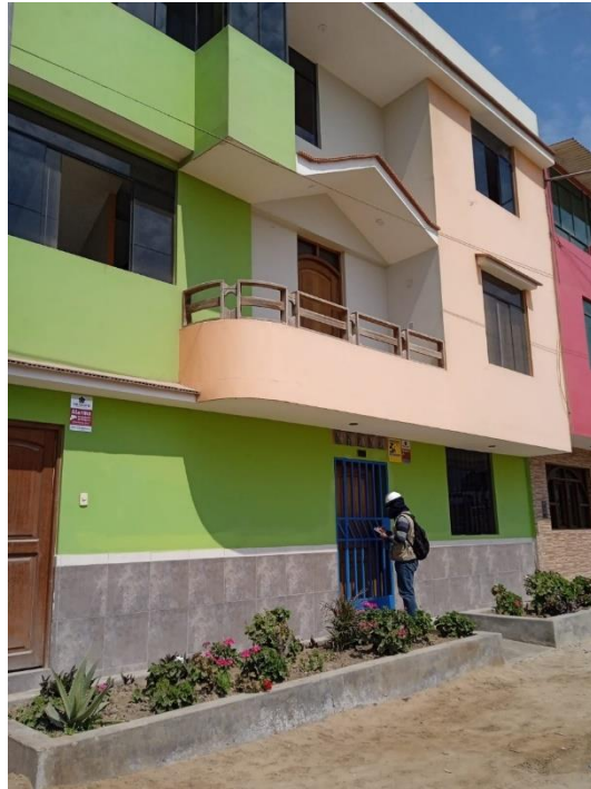
Anexo 7.5. Fachada de la vivienda 10 ubicada en la Mz. 13 Lt. 6.
