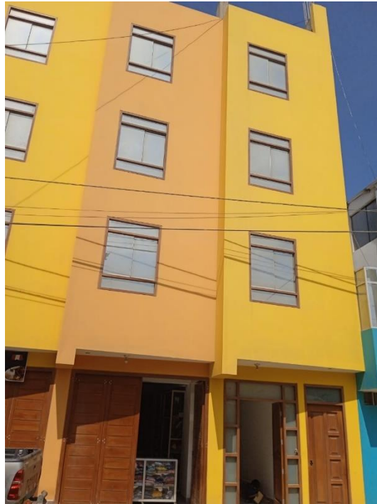
Anexo 7.9. Fachada de la vivienda 24 ubicada en la Mz. 7 Lt. 4.
