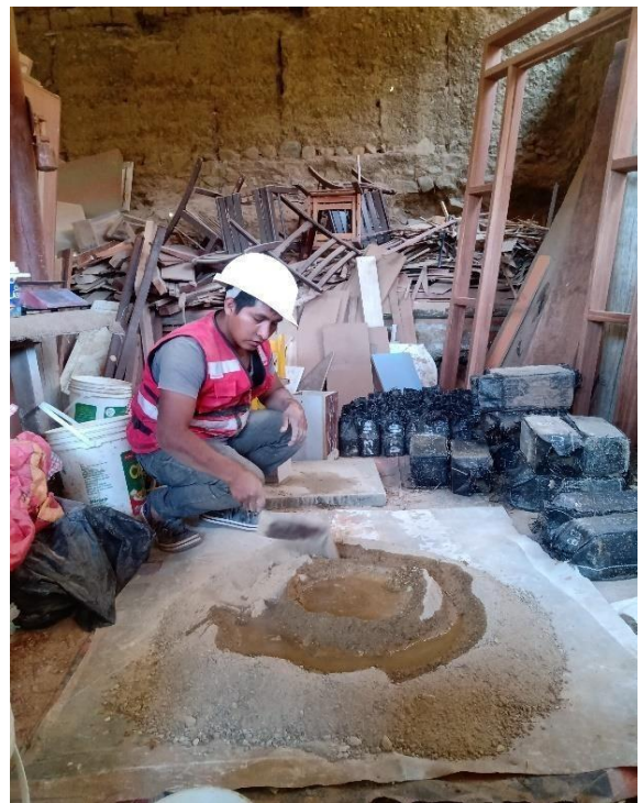
Figura 8. Preparación de la mezcla con agua. Fuente: elaboración propia
