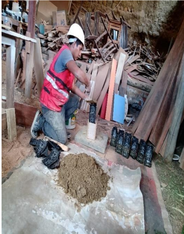
Figura 9. Llenado de la mezcla a los Sacos de polipropileno y el molde. Fuente: elaboración propia
