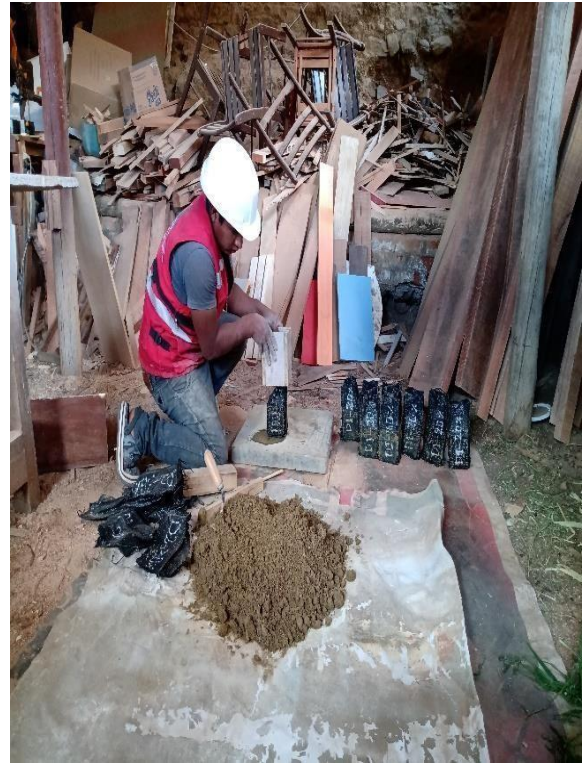
Figura 10. Extracción del superadobe desde el molde. Fuente: elaboración propia
