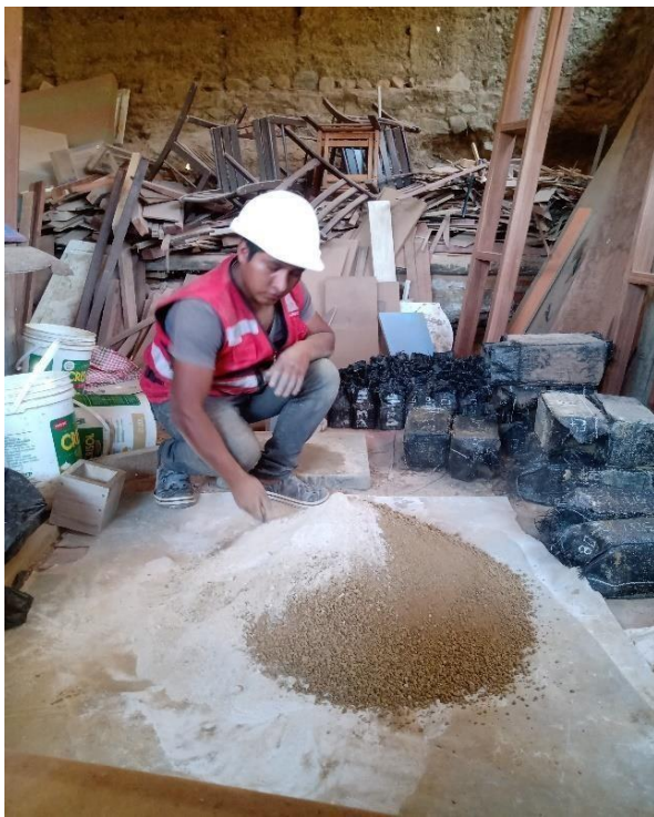
Figura 7. Mezcla en seco del relave minero, cal y tierra Fuente: elaboración propia
