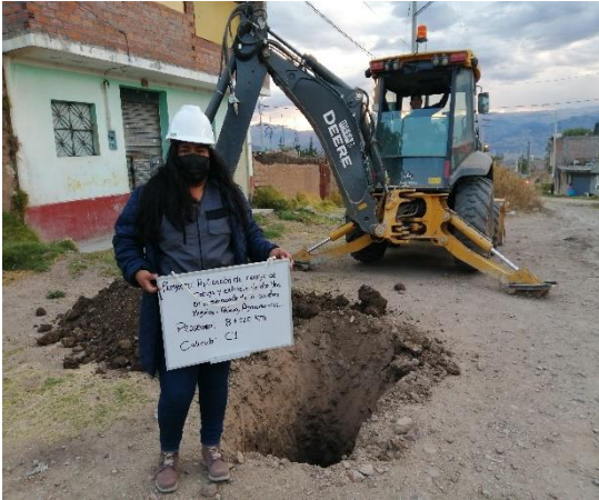
Figura 06 : Calicara - 01 Fuente: Elaboracion propia
