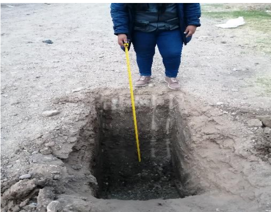
Figura 08: Calicata - 03 Fuente : Elaboración Propia.
