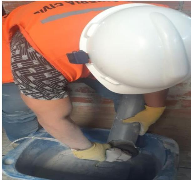
Figura 7. Pulverización de PVC
