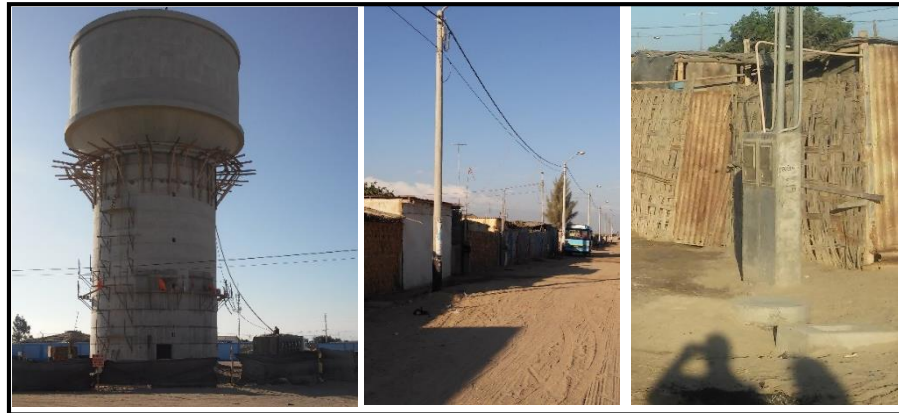
IMAGEN N°21: FOTOGRAFÍAS DE SERVICIOS PÚBLICOS FUENTE: Autoría Propia
