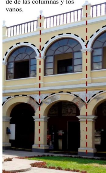
Patio de ingreso Fotografía (11/04/2014)
