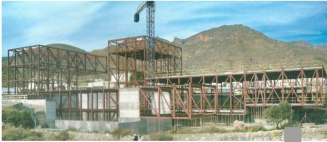
1. Estructura principal – sistema de tijerales
