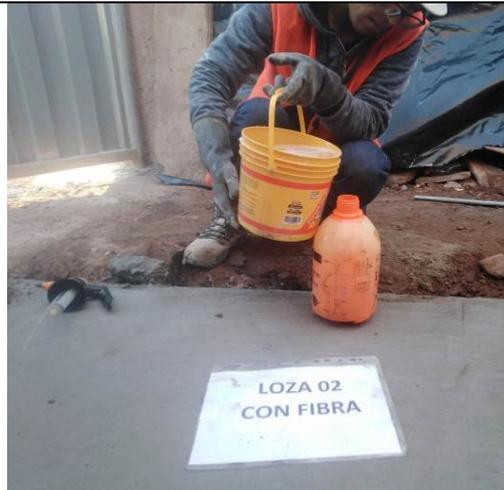
*Figura 44.* Preparado de aditivo para curado de losa
