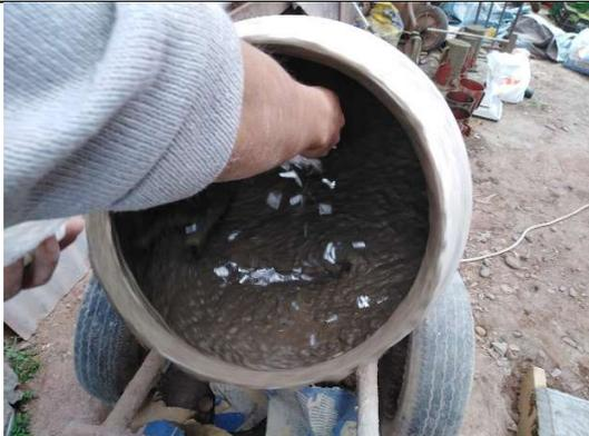
*Figura 29.* Adicion de microfibra de polipropileno
