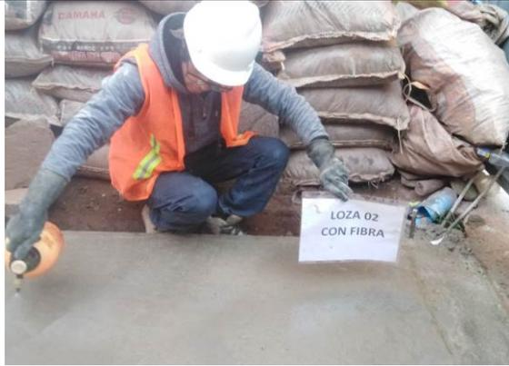
*Figura 45.* Aplicación de aditivo de losa
