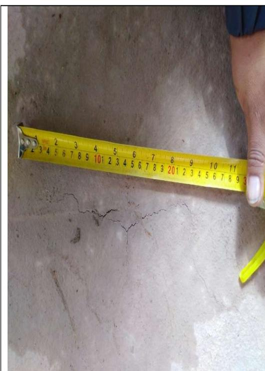
*Figura 14.* Fisura por contracción en losa de concreto convencional
