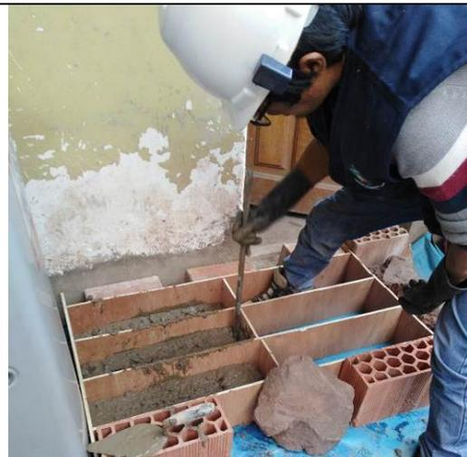
**Figura 36.** Se realiza vaciado de vigas de flexion
