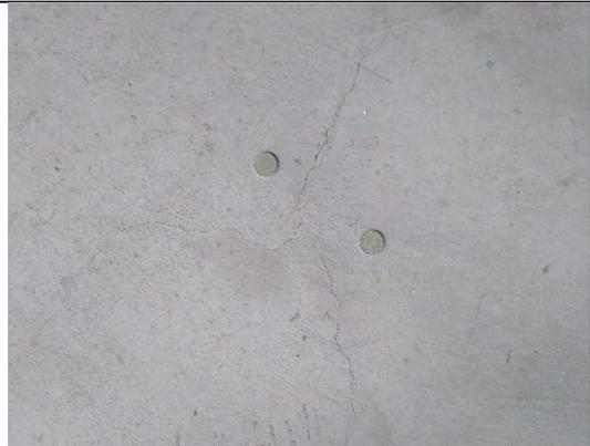
*Figura 48.* Fisuración en losa de concreto convencional.
