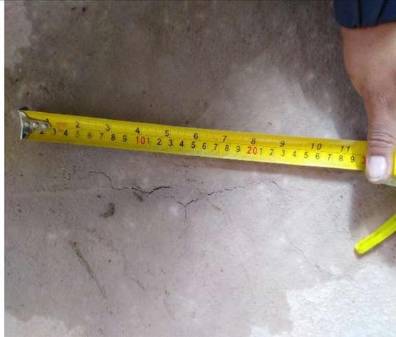
**Figura 49.** Presencia de fisuras en losa de concreto convencional
