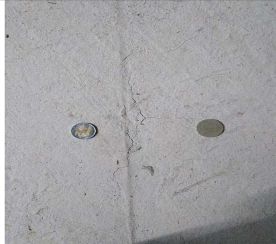
**Figura 50.** Fisuras en losa de concreto
