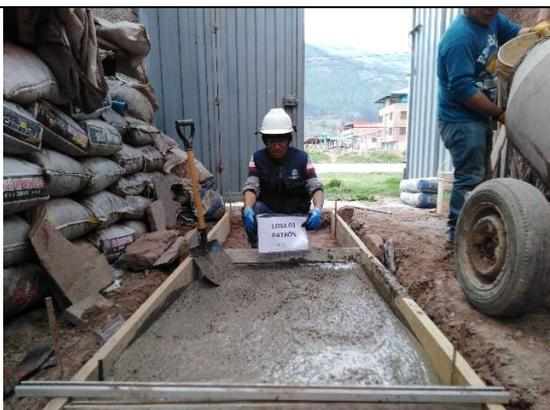
*Figura 31.* Vaciado de losa de concreto
