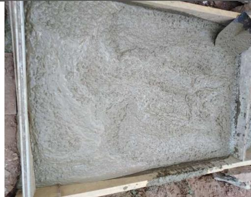
*Figura 30.* Vaciado de losa de concreto convencional
