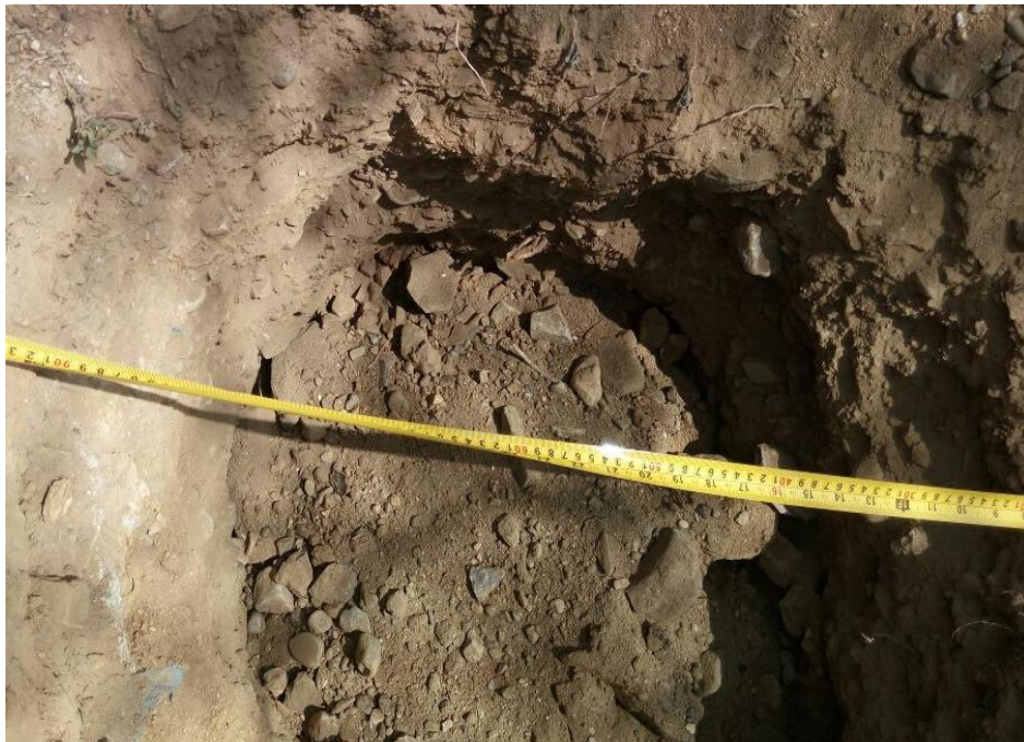
Ancho de la Calicata N° 1 fue de 1 metro
