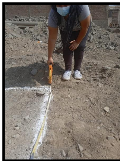
Figura 5. Marcando las calicatas
