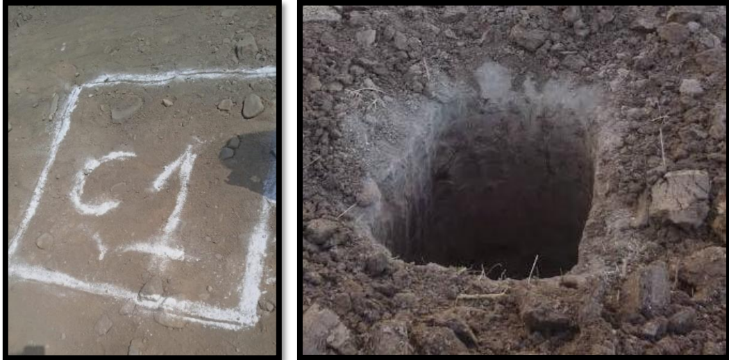
Figura 6. Ubicación de la calicata 1.
