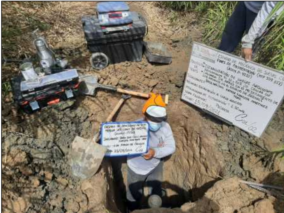
Imagen 05: Excavación de calicata C-1
