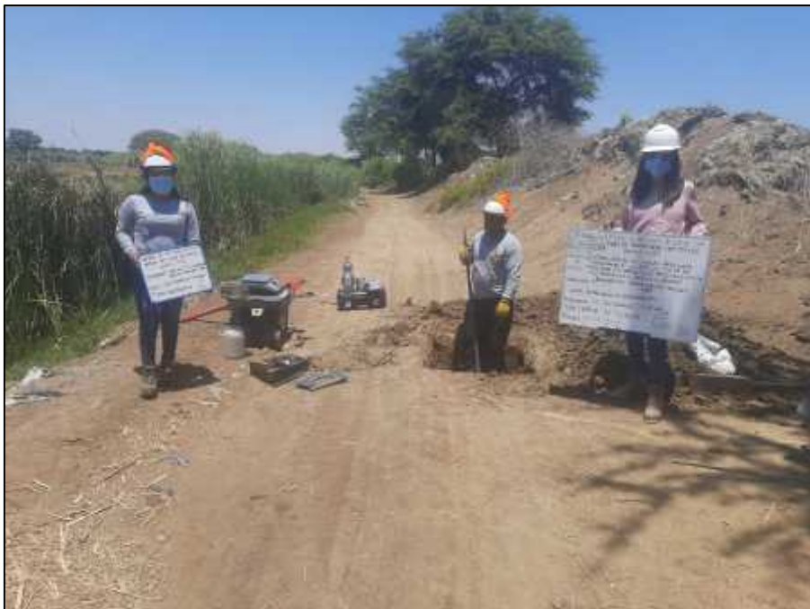
Imagen 05: Excavación de calicata C-2
