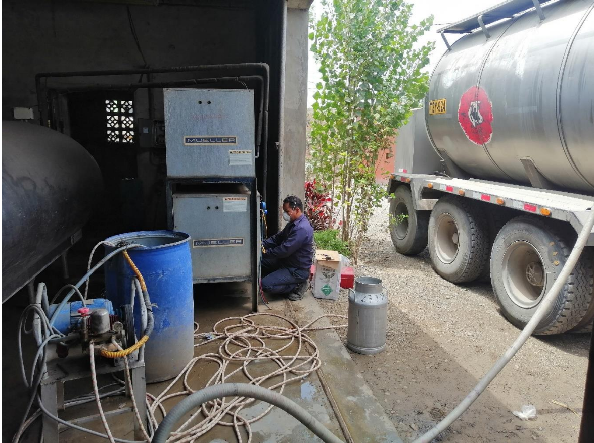
Figura 37. Realizar mantenimientos básicos al equipo
