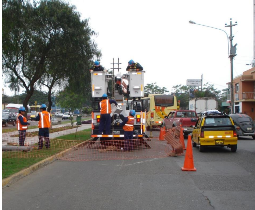
Figura 14. Inspecciones realizadas con el Brazo
