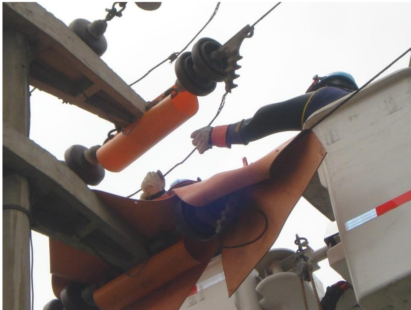
Figura 18. Cambios de cables efectuados
