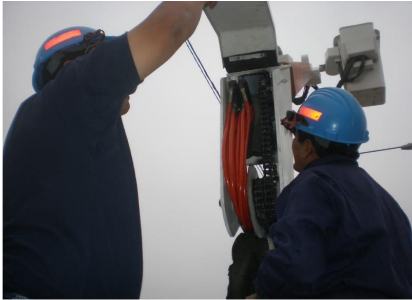
Figura 11. Revisión visual de mangueras aislantes los equipos
