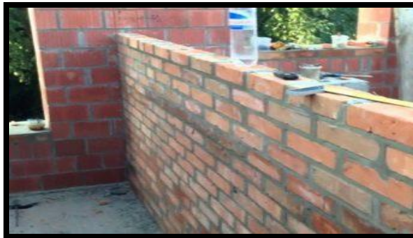
Figura 5. Muros no portantes
