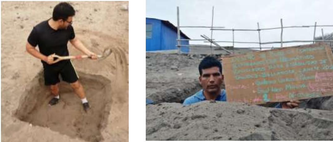
Figura 08.- Calicata (excavación manual)
