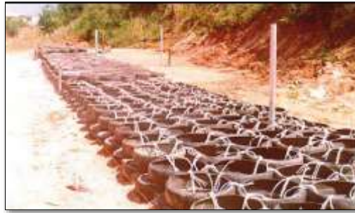
Figura 14.- Amarre de neumáticos con cuerda de polipropileno.
