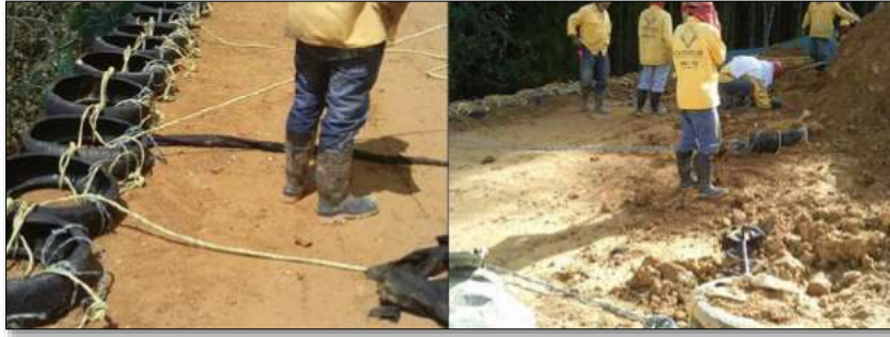
Figura 17.- Amarre de neumáticos y tensores.
