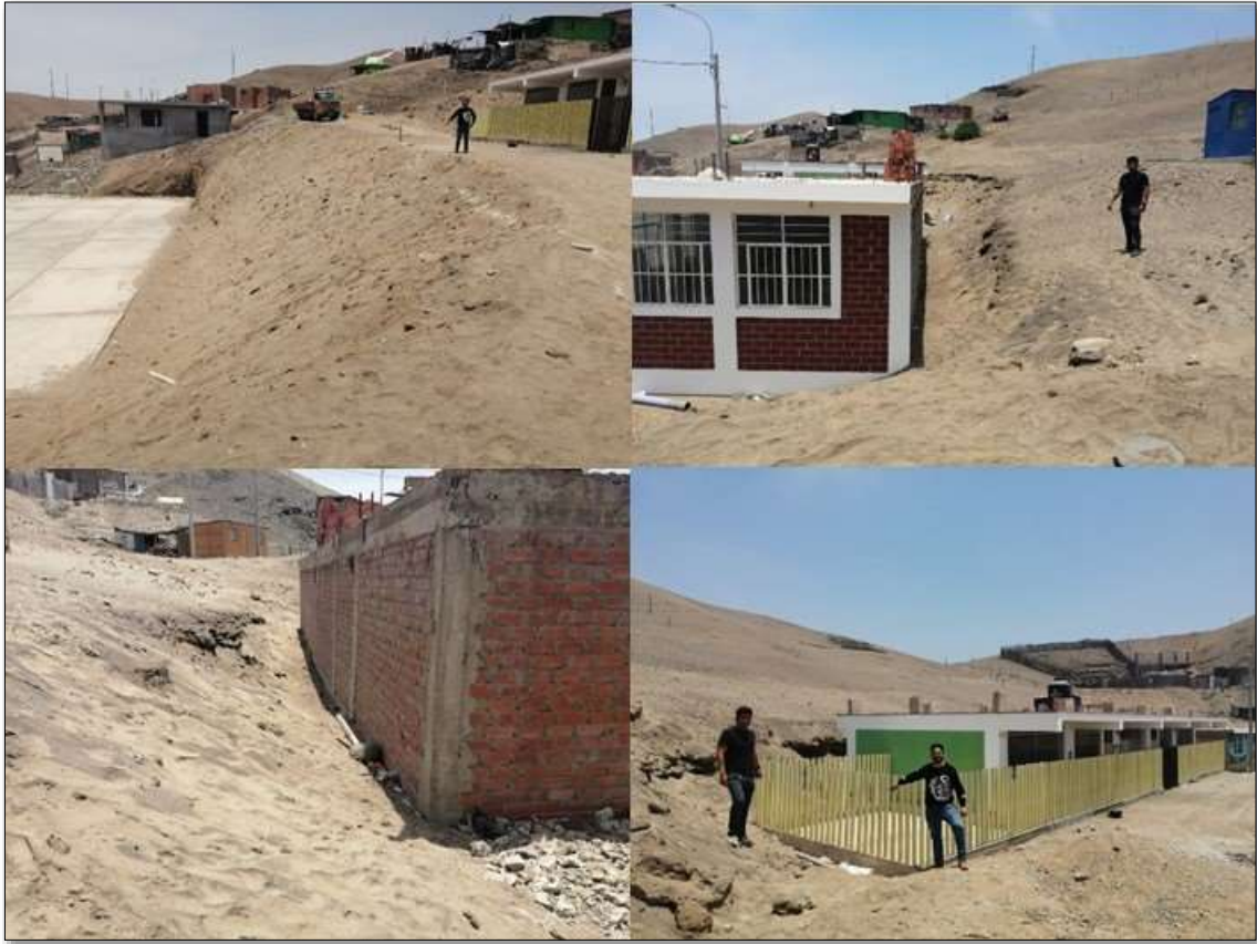
Figura 02.- Talud en Bellavista
