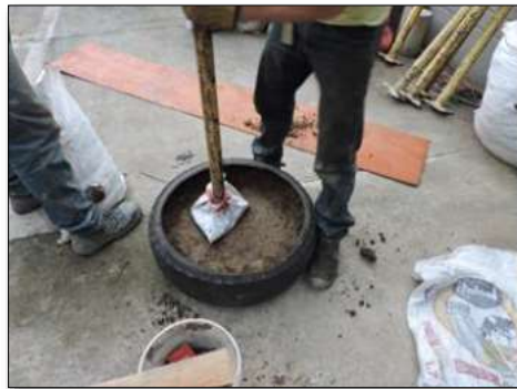
Figura 13.- Relleno con concreto del neumático.
