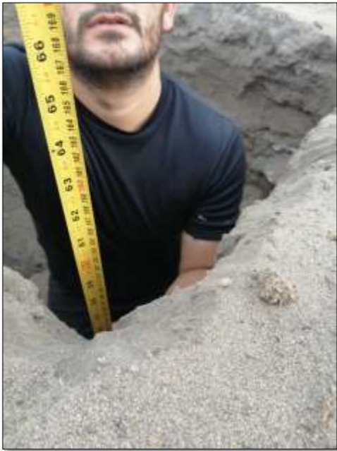
Calicata para recoger la muestra del terreno y enviar a laboratorio
