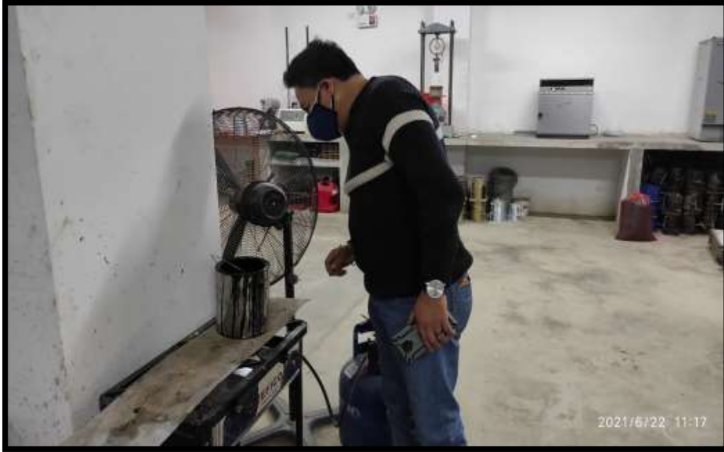
Figura n° 40 Calentamiento de asfalto para ser utilizado
