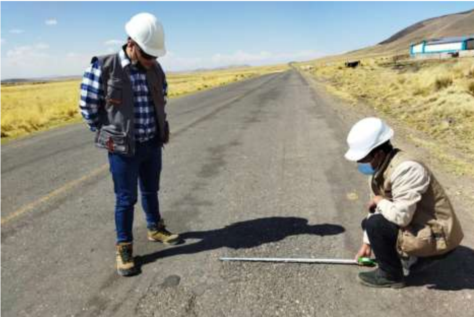
IMAGEN 1: Reconocimiento de la carretera puno - mañazo
