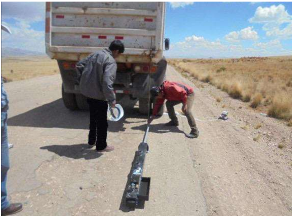
IMAGEN 9: COLOCACIÓN DE LA VIGA BENKELMAN ENTRE LAS LLANTAS DEL EJE POSTERIOR DEL CAMIÓN.
