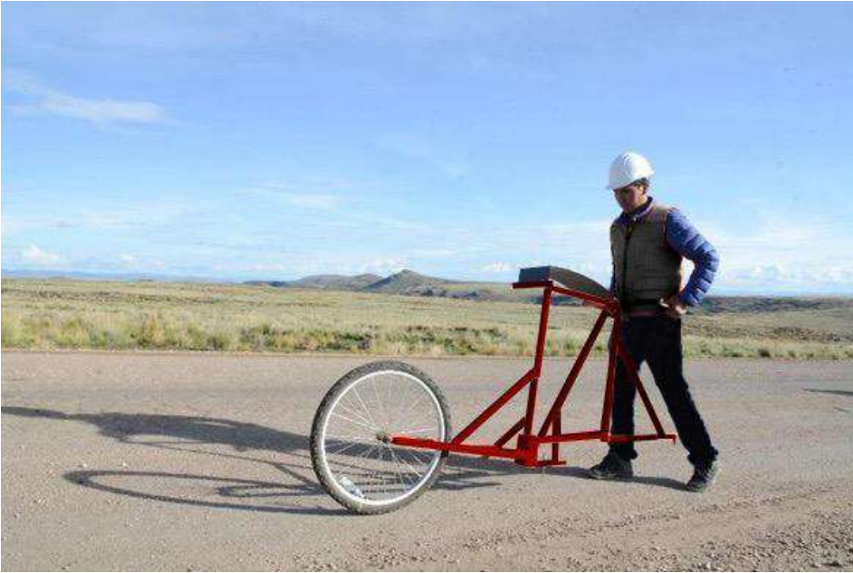
IMAGEN 5: REALIZANDO EN ENSAYO DE RUGOSIMETRO MERLIN, PARA EL CALCULO DE FACTOR DE CORRECCIÓN.
