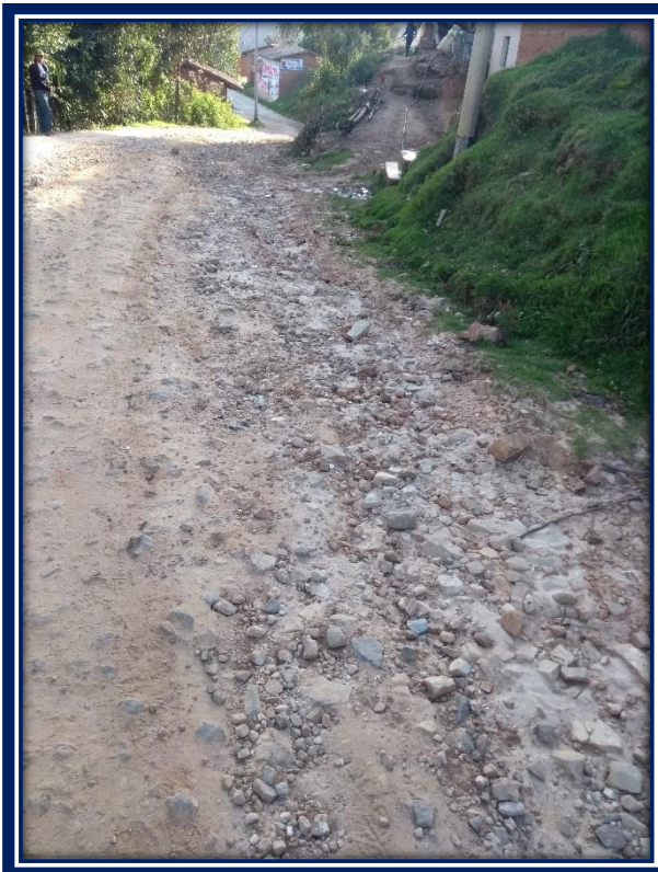
FOTO 3. Deterioro de la carretera ocasionada por el tránsito de camiones de carga
