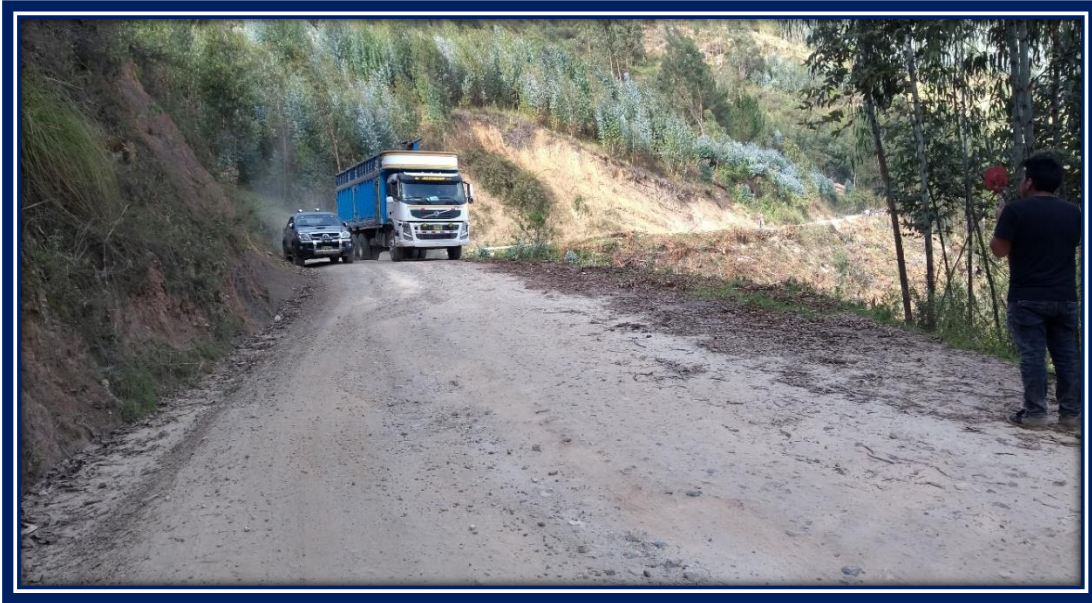
FOTO 8. Falta de señalización en el Tramo Curgos – Huangabal – El Edén
