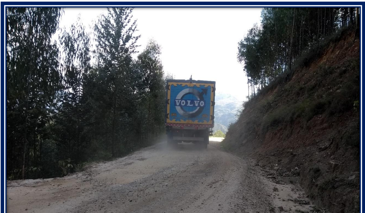
FOTO 5. Inestabilidad de taludes
