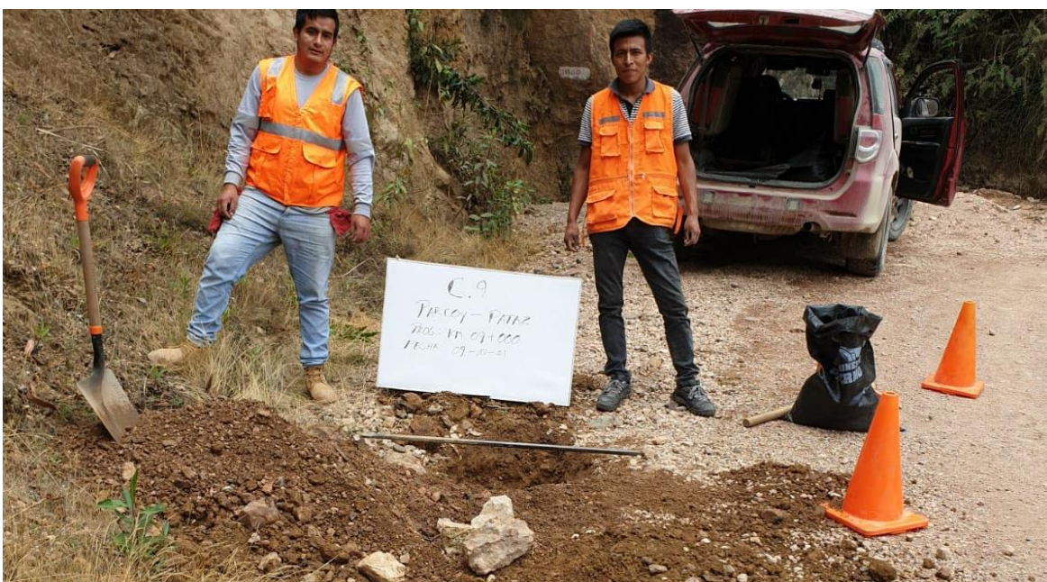
Excavación y extracción de muestras de la calicata N° 09
