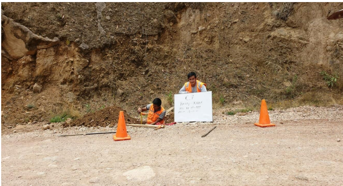
Excavación y extracción de muestras de la calicata N° 07
