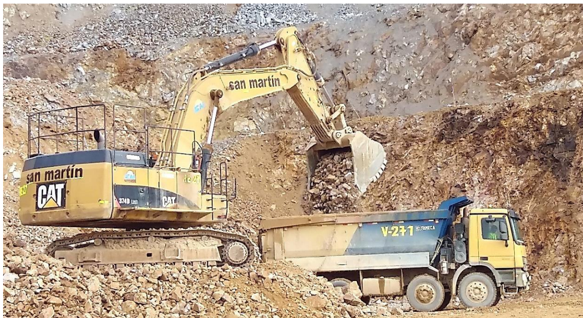
Foto 14. Proceso de Carguío (Excavadora 374 DL)
