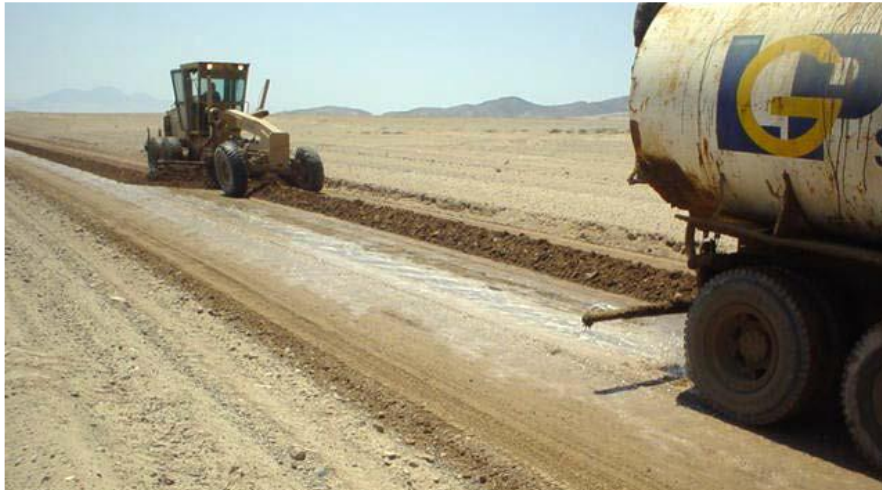
Foto 13, Regado con agua de la vía con el material de cantera mejorado
