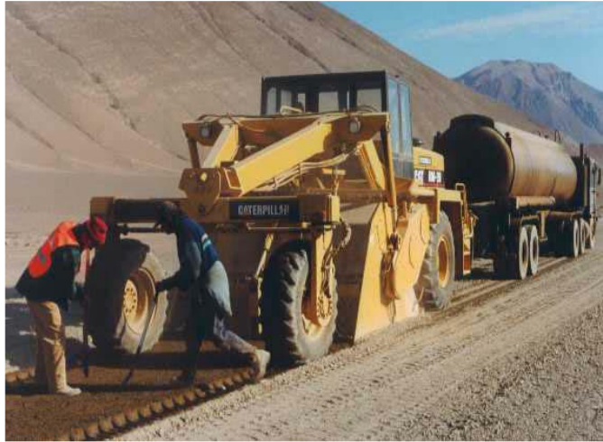
Foto 11 Colocación de material de cantera con sal industrial.
