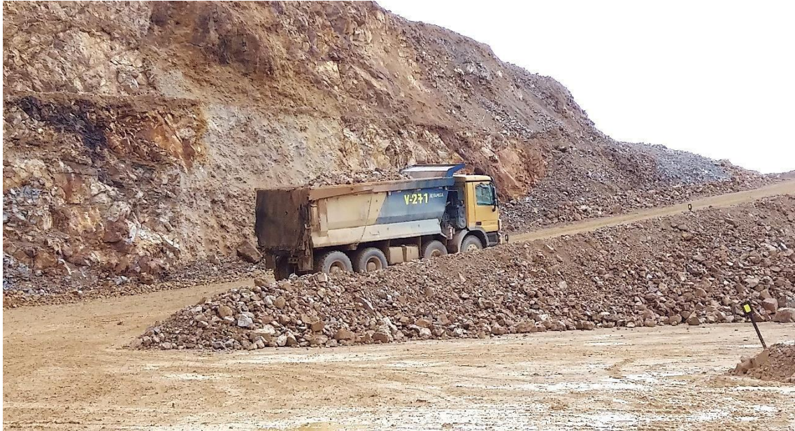
Foto 15. Proceso de Transporte de Acarreo (Volquetes de 20 cubos)
