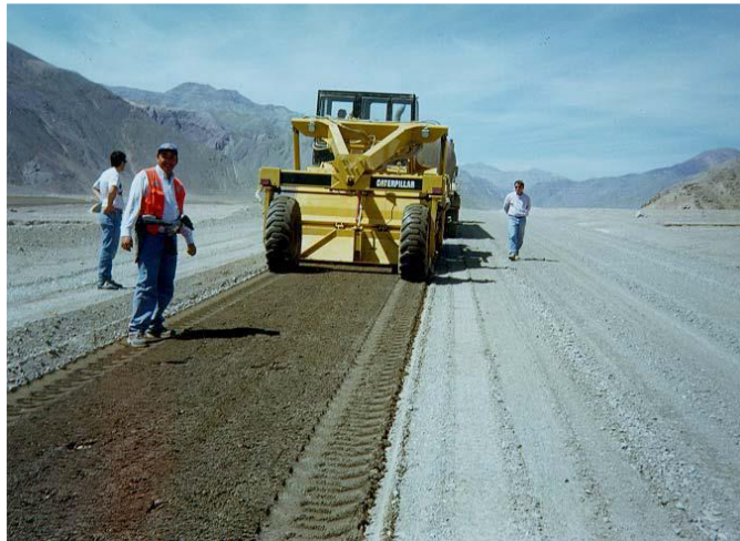
Foto 12. Esparcido y nivelado de material de cantera con sal industrial
