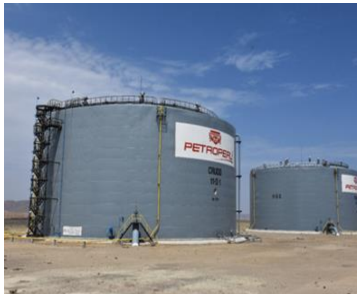
Figura 3. Tanque de almacenamiento petróleo 126 mil barriles de capacidad
