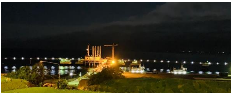
Figura 12. Iluminación muelle Terminal Bayóvar.
