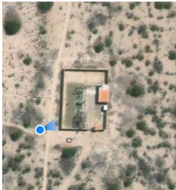
Figura 16. Vista aérea Sub-Estación Constante Fuente: Terminal Bayóvar elaboración propia
