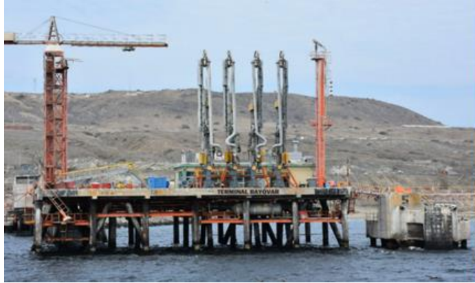
Figura 1. Brazos de carga de 16"· Capacidad: 25 mil barriles/hora
