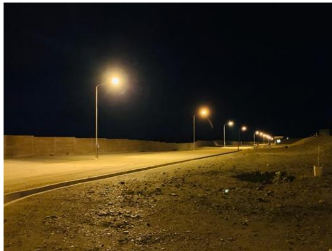
Figura 13. Iluminación Camino a Patio Tanques.
