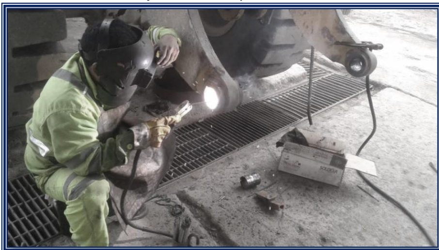
FIGURA 3: Rellenado de alojamientos de pines con electrodo de soldadura
