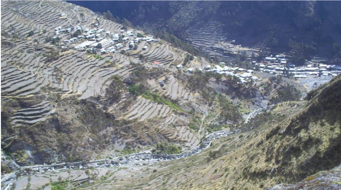
Figura 2 : topografía y pendiente del talud
