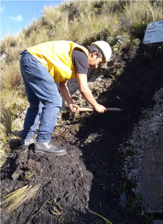
Figura 45 Excavación de calicata
