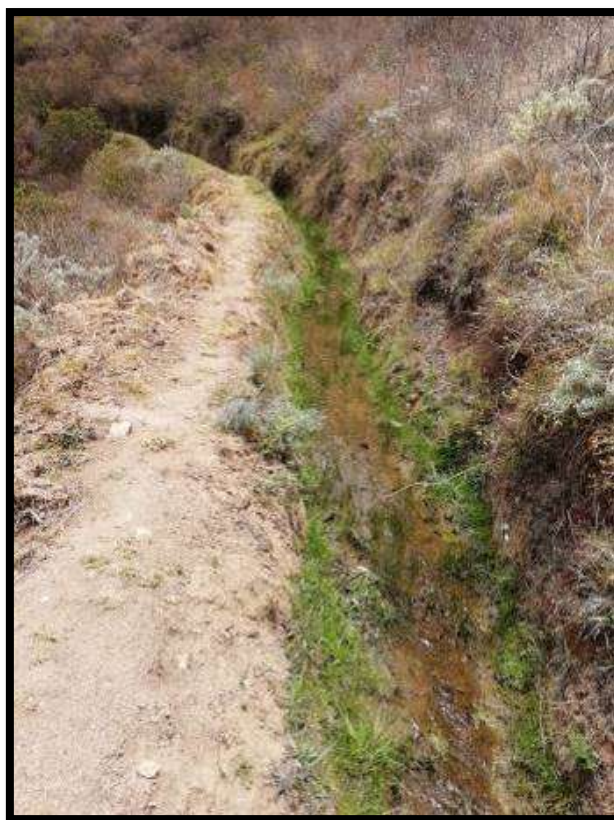
Figura 27: Véase línea de tierra, por donde pasa la red de distribución
