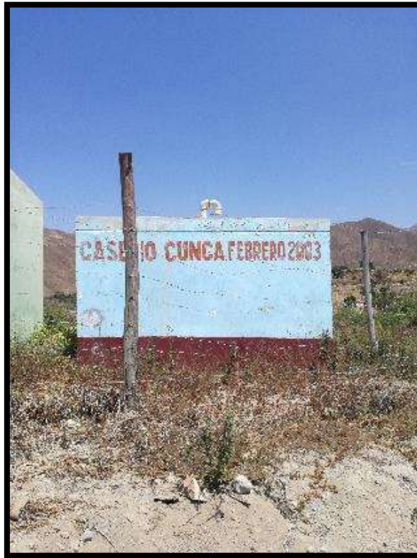
Figura 22: Vista general de la estructura del reservorio
