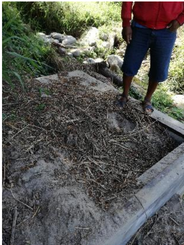
Foto 02. Captación N° 02 por rehabilitar
