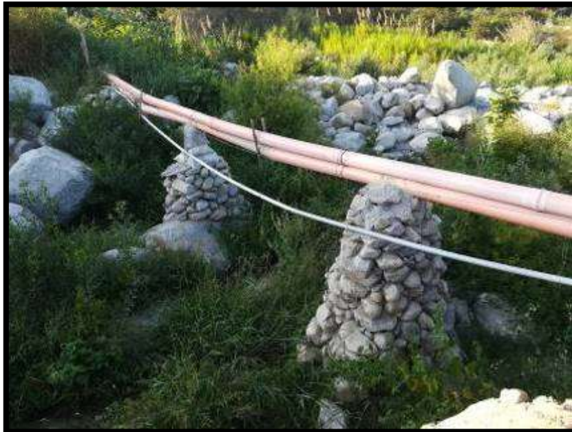
Figura 14: Vista del tramo del pase aéreo, en donde se verifica que se requiere la construcción de una estructura con columnas y cableado, esta para optimizar el servicio.
