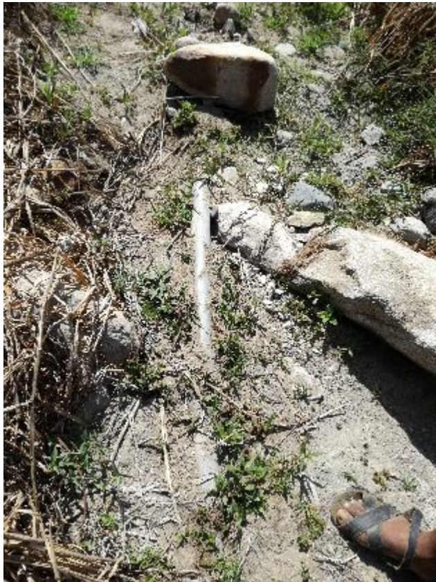
Foto 08. Tubería sobre terreno rocoso
