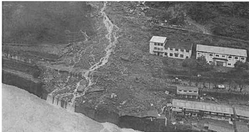
Gráfico N° 17: Daños por Deslizamientos
