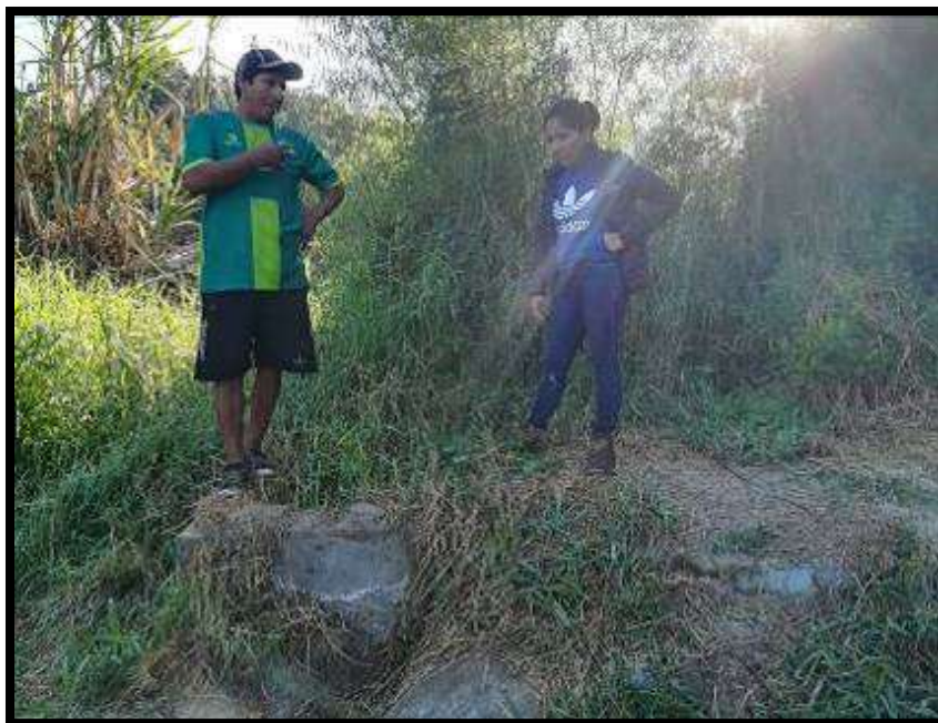
Figura 11 – La estructura se encuentra totalmente oculta por la tierra y vegetación
