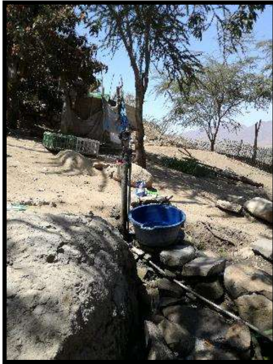
Figura 34: Vista de grifos de uso domiciliario vigente, apréciese la exposición de los conductos ante posibles amenazas.
