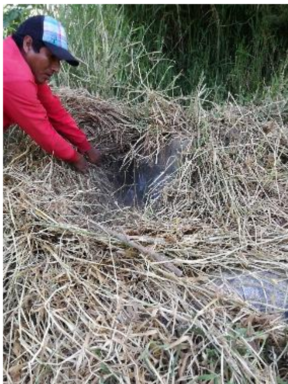
Foto 01. Captación N° 01 afectada por Huayco
