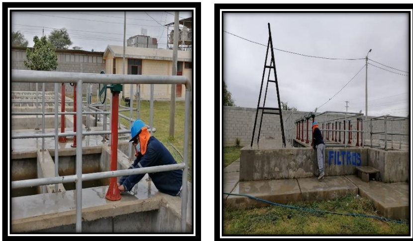
Figura Nº 11: Ajuste de compuerta de pie de maniobra
