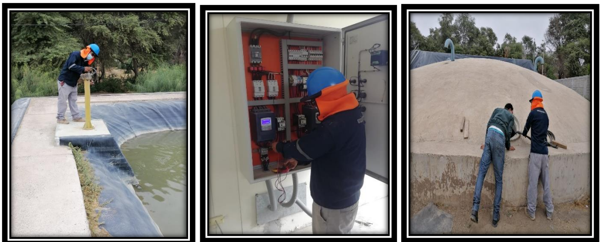
Figura Nº 12: inspección de equipos durante el proceso
