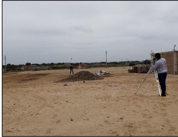
Figura 03: Levantamiento topográfico de zona de estudio
