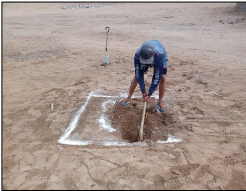
Figura 15: Excavación de calicatas a cielo abierto
