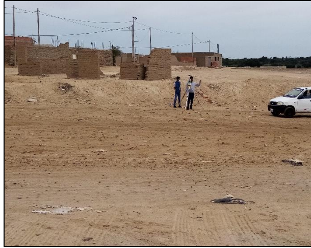
Figura 06: Levantamiento topográfico de zona de estudio
