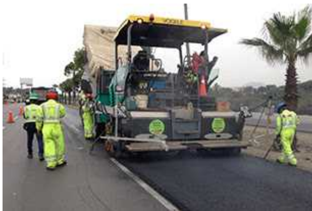
Figura 4. Mezcla asfáltica en caliente
