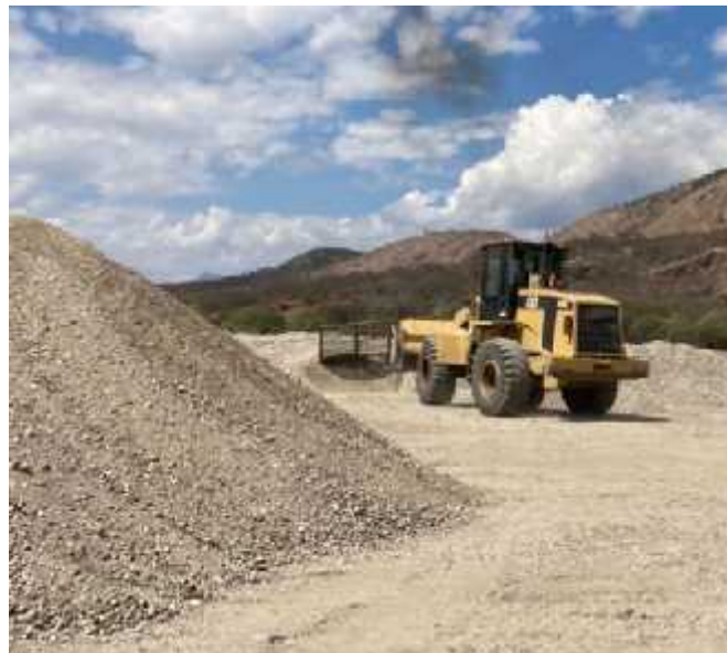
Figura 37. Recojo de agregados de la cantera de Rumichuco – Tacllan.
