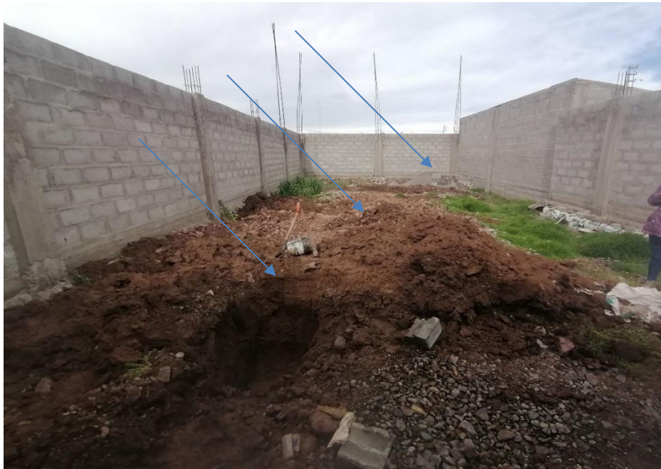
Ubicación de Calicatas 1,2 y 3
