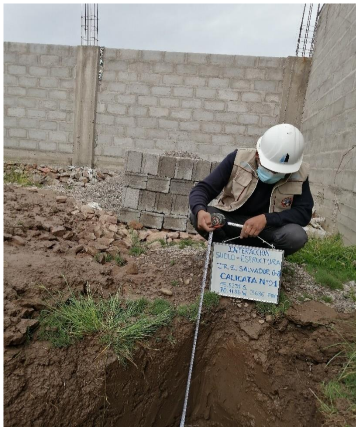
Profundidad de Calicatas 3 metros
