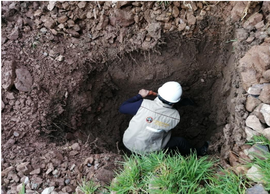
Excavación de Calicata 2
