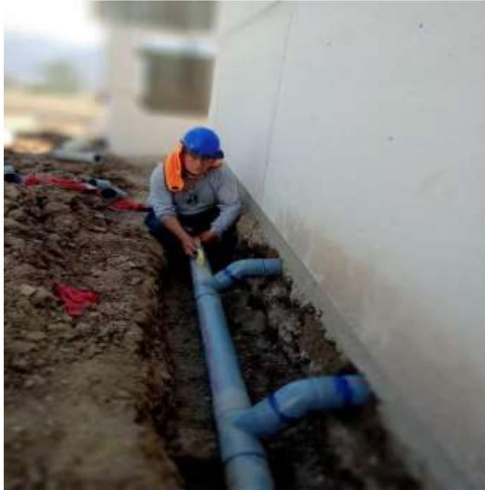
**Figura 5: Cambio de tuberías de desagüe sin EPP**
