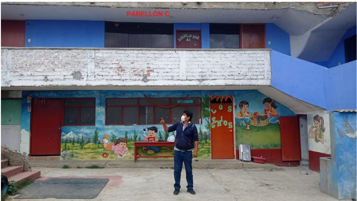
Fotografía del Pabellón C
