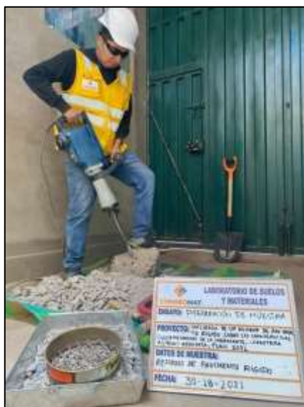
Figura 11. Trituración del concreto
