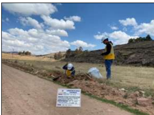
Figura 9. Excavación de la calicata
