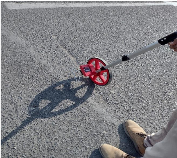
Figura N° 66: grieta longitudinales y transversales
