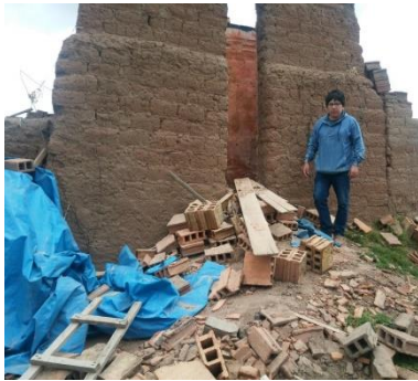
Fotografía 4. Horno tipo escoces de cocción de ladrillo artesanal.
