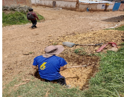
Figura 2. Excavación de la calicata.
