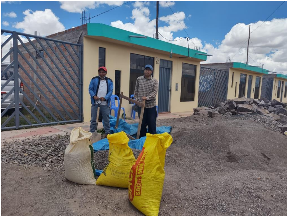
Figura 14: Acumulando material de 3/8" en sacos para realizar las probetas.
