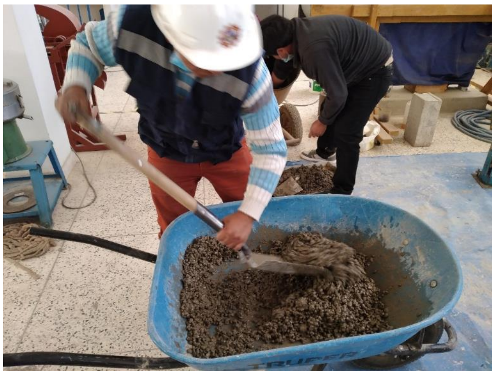
Figura 24: Revolviendo la mezcla después de extraerlo de la mezcladora.
