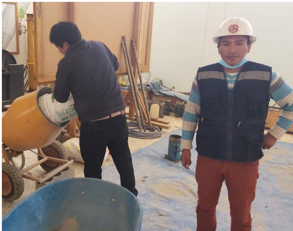
Figura 23: Agregando materiales a la mezcladora.
