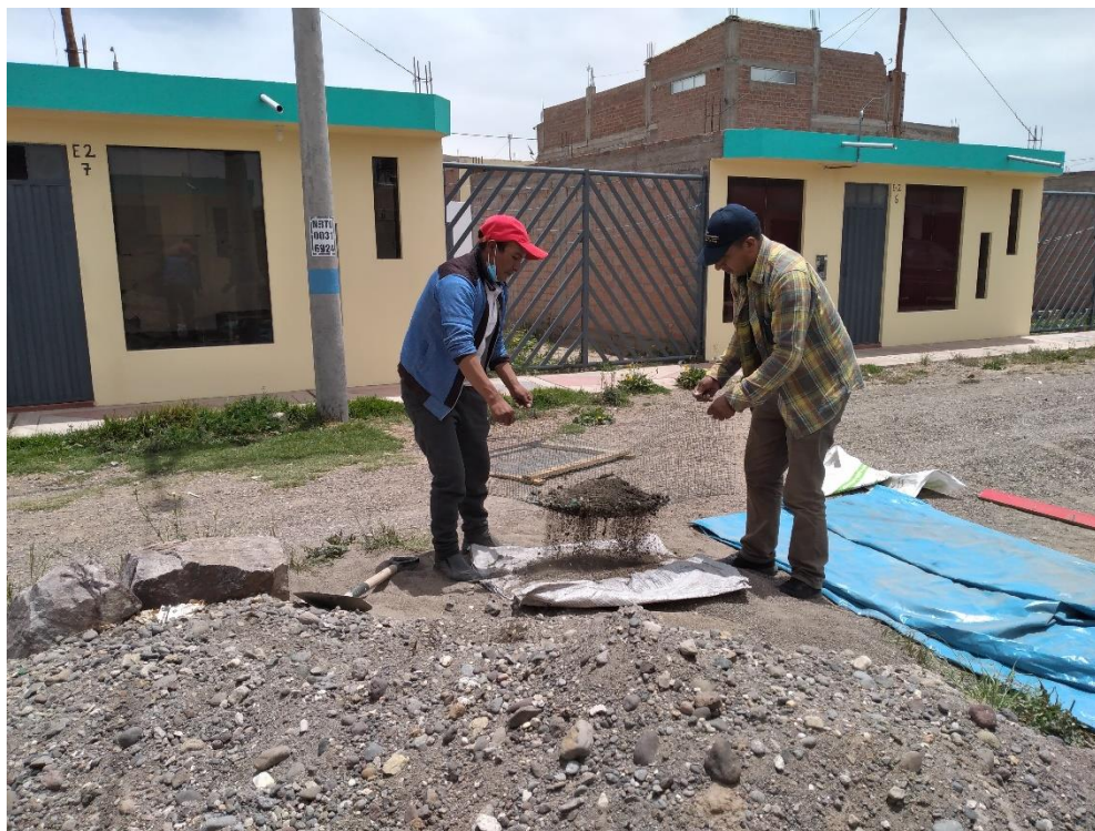
Figura 09: Zarandeando agregado grueso por la malla de \frac{1}{2} " para recolectar material de \frac{3}{8} ".
