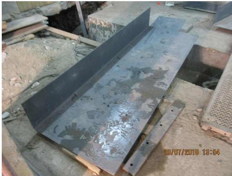
Figura 21. Detalle de Plancha Metálica
