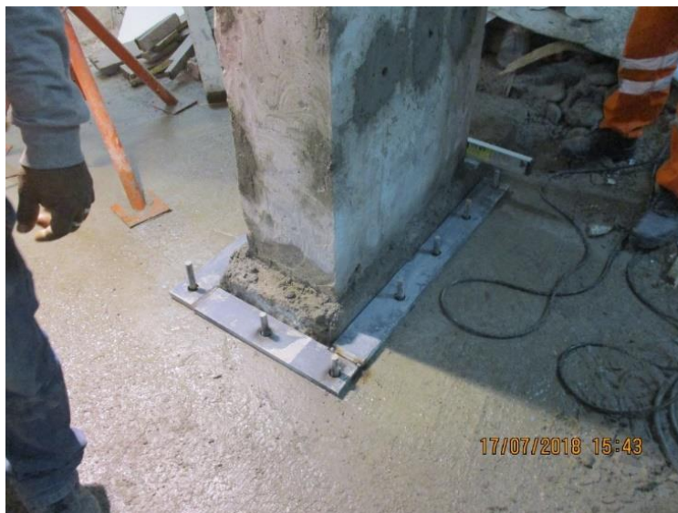
Figura 18. Instalación de platina en zapata existente
