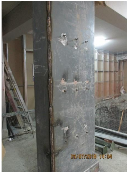
Figura 23. Columna soldada con pernos pasantes
