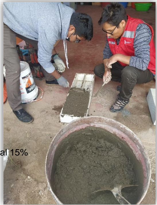
Fotografía 19. Preparación concreta para elaboración de vigas.
