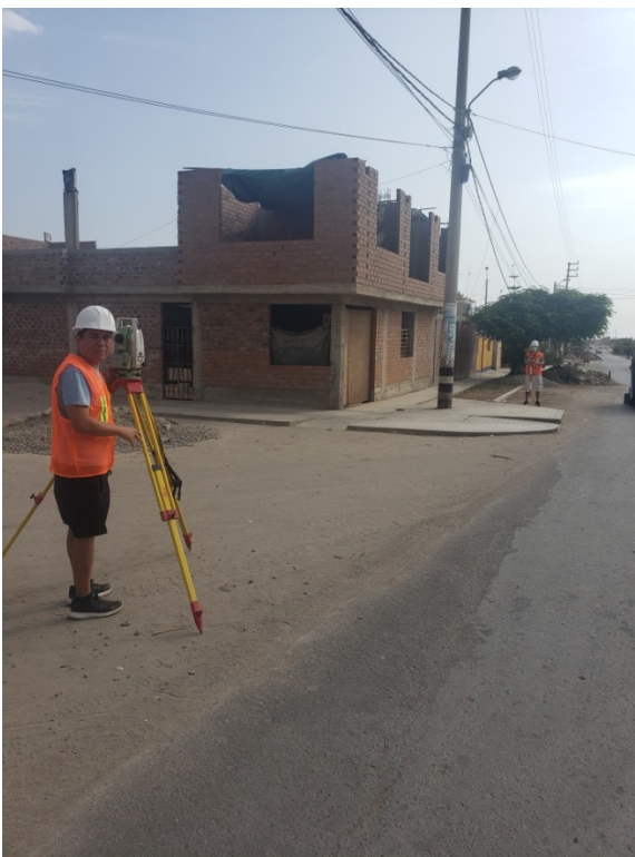
Foto 12. Estación de irradiación de puntos en la Prlg. Av. Bombon Coronado
