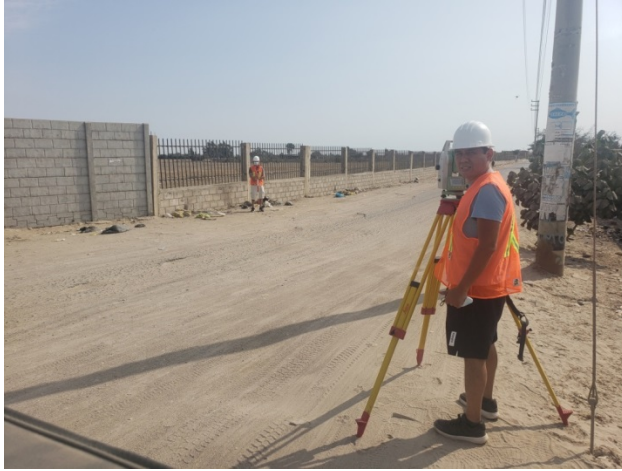
Figura 14 Estación de irradiación de puntos en la Prlg. Av. Bombon Coronado
