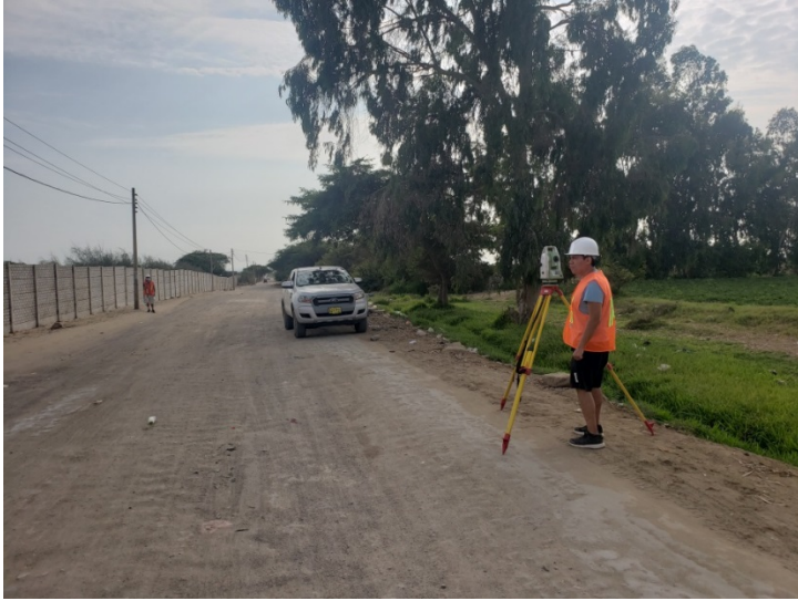
Foto 14. Estación de irradiación de puntos en la Prlg. Av. Bombon Coronado
