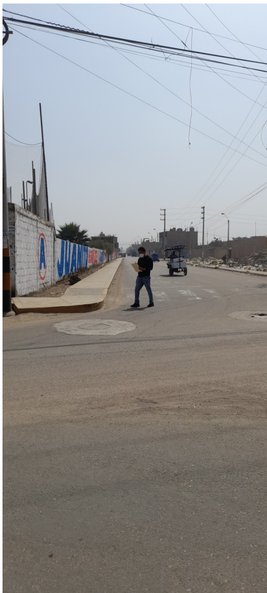
Foto 1: Punto de empalme con tubería principal existente
