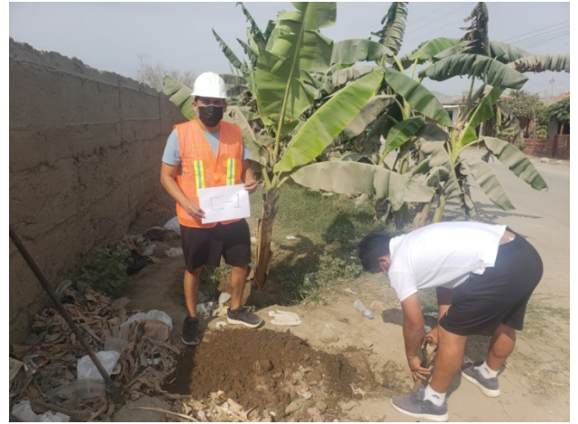
Figura 15. Excavación de la calicata N° 01 para la extracción de la muestra en Prlg. Av. Bombon Coronado
