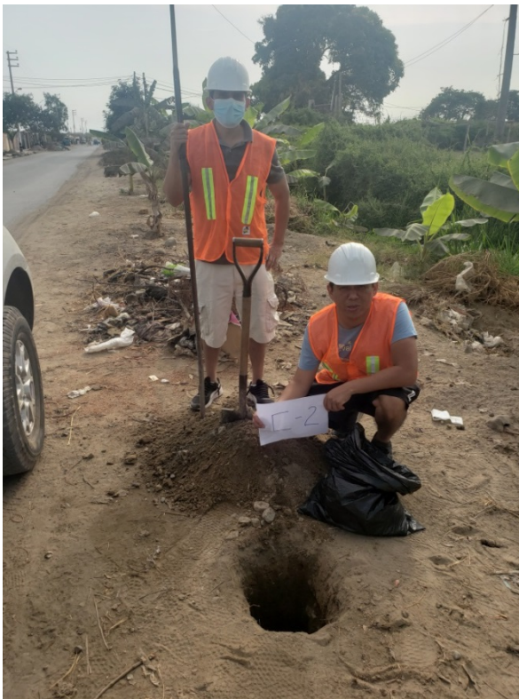
Figura 16 Excavación de la calicata N° 02 para la extracción de la muestra en Prlg. Av. Bombon Coronado
