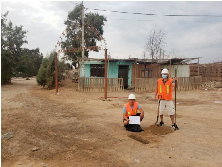
Foto 22. Excavación de la calicata N° 04 para la extracción de la muestra en el AA.HH. 12 de Septiembre
