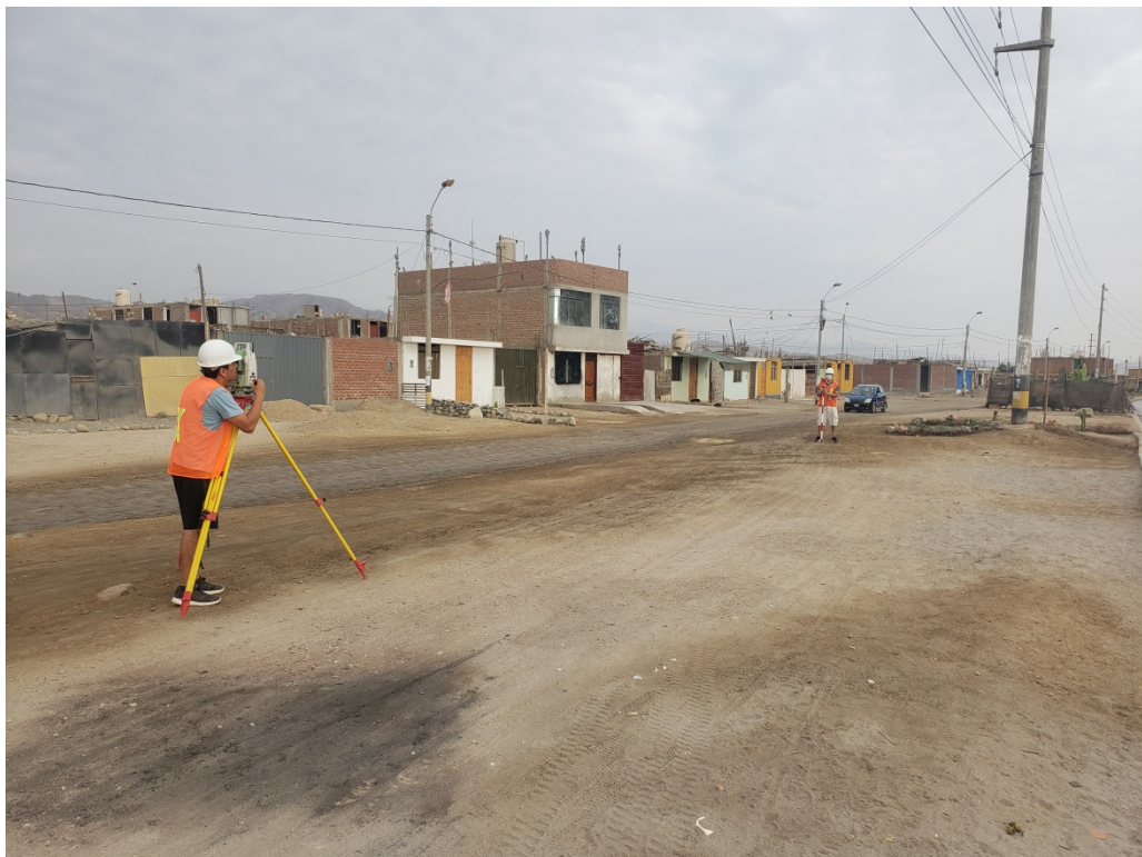
Foto 19. Estación de irradiación de puntos en el AA.HH. 12 de Septiembre
