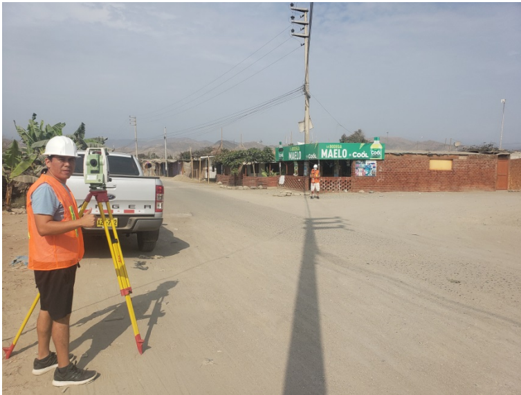
Foto 10. Estación de irradiación de puntos en la Prlg. Av. Bombon Coronado
