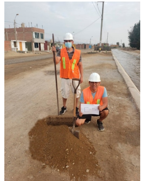
Foto 23. Excavación de la calicata N° 05 para la extracción de la muestra en el AA.HH. 12 de Septiembre
