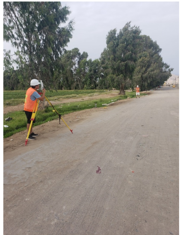
Foto 13. Estación de irradiación de puntos en la Prlg. Av. Bombon Coronado
