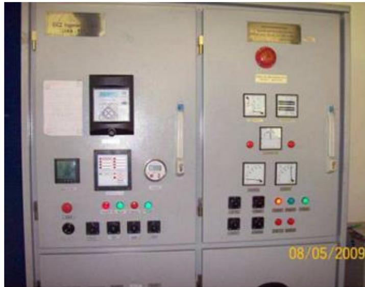
*Figura 10:* Tablero de mando, control y protección turbina Francis
