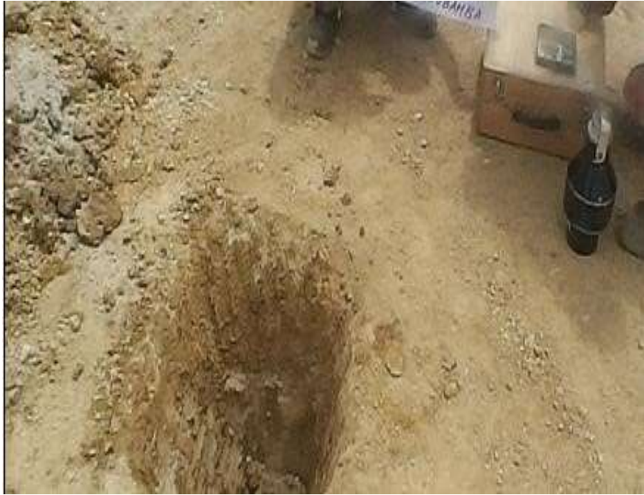
Figura N°16: Excavación de calicata N°01 y toma de muestra.
