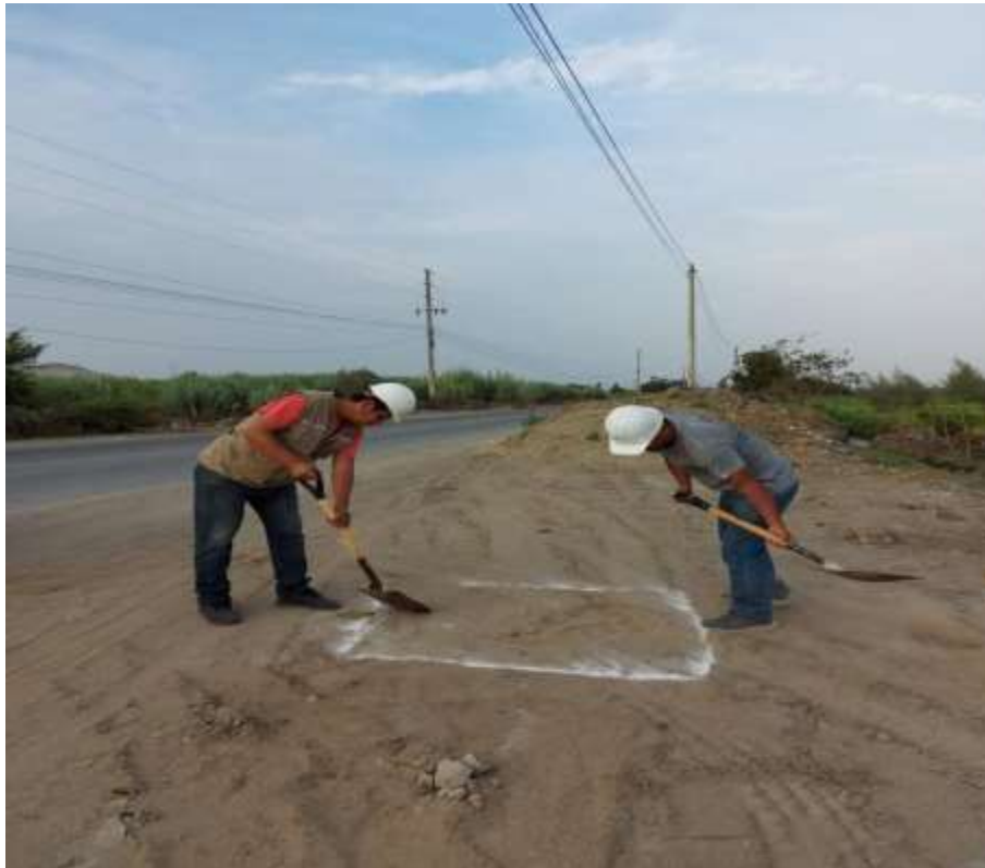
Figura N°14: Demarcación de calicata N°03, para su posterior excavación.
