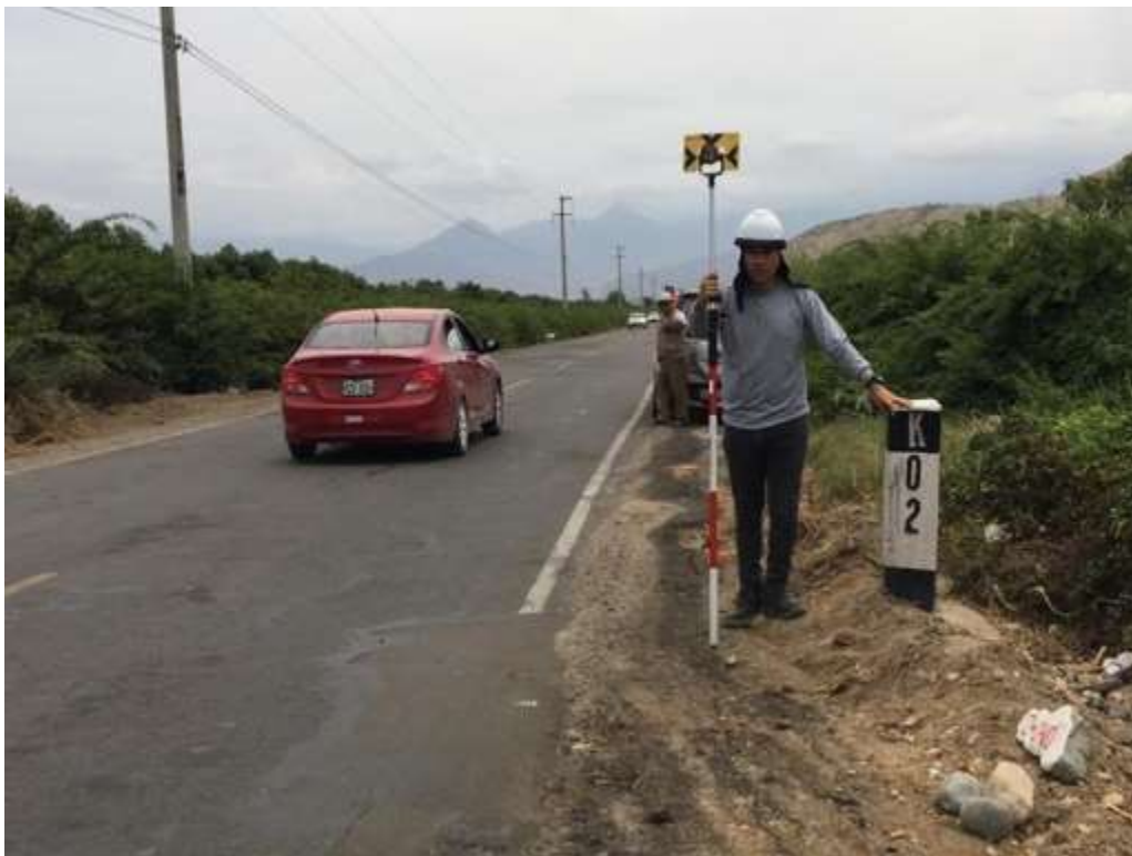
Figura 11. Alineamientos con el teodolito tramo Cambio Puente
