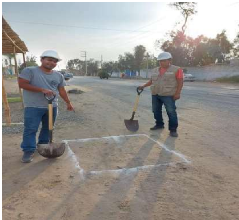
Figura N°15: Demarcación de calicata N°04, para su posterior excavación.
