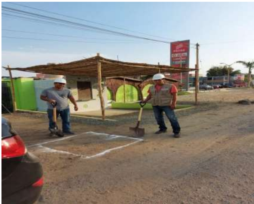
Figura N°13: Demarcación de calicata N°02, para su posterior excavación.
