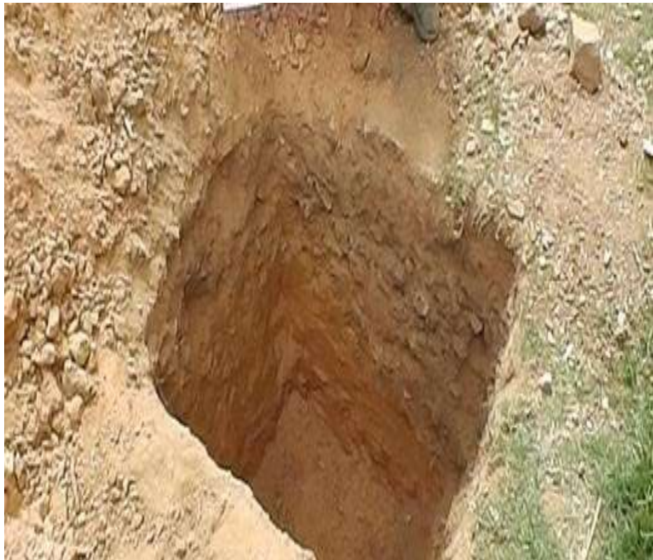
Figura N°17: Excavación de calicata N°04 y toma de muestra.
