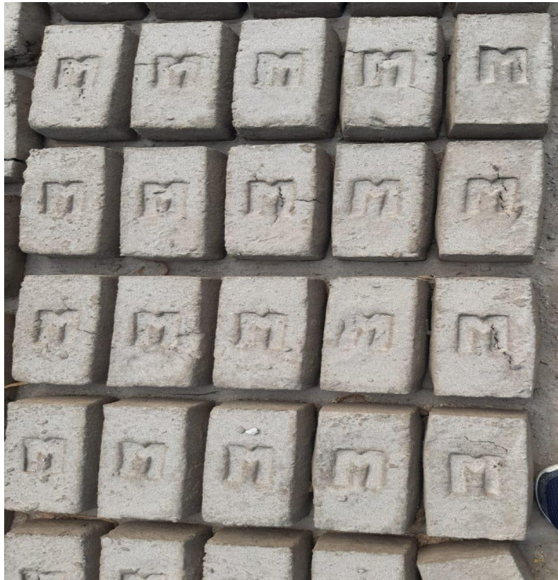
Figura 22: Agrietamiento en ladrillo con adición 6% de fibra cacao y algarroba
