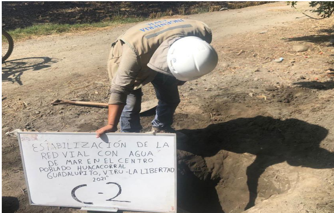
Fotografía N° 04. Finalizando la calicata N° 02 para la obtención de muestras del Centro Poblado Huacacorrall.
