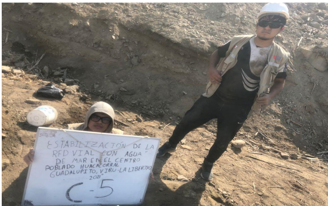
Fotografía N° 07. Finalizando la calicata N° 05 para la obtención de muestras del Centro Poblado Huacacorrall.
