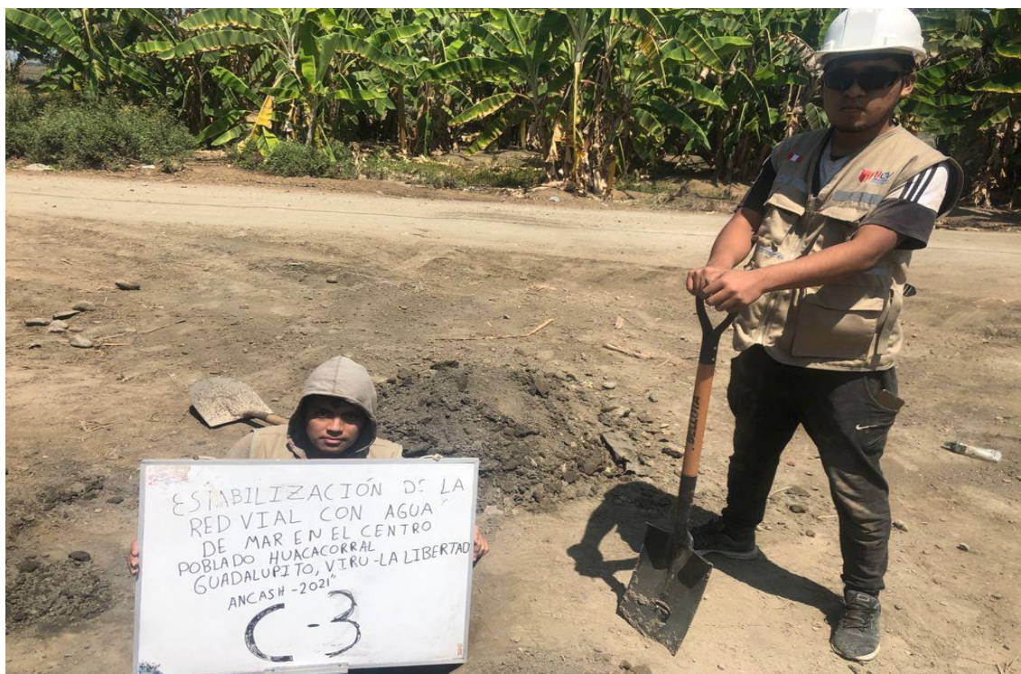
Fotografía N° 05. Finalizando la calicata N° 03 para la obtención de muestras del Centro Poblado Huacacorral.
