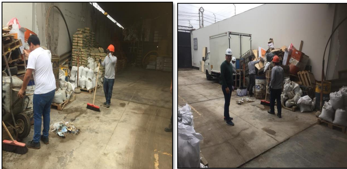
Figura 22. Limpieza del almacén de Construedes S.A.C.
