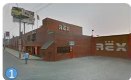
1 Núcleo industrial, avenida Alfredo Mendiola, SMP Fuente: captura de google maps.
