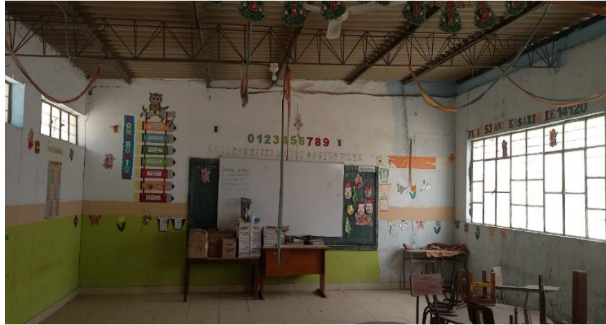
Figura 54. Conexión Muro-Techo en módulo 2
