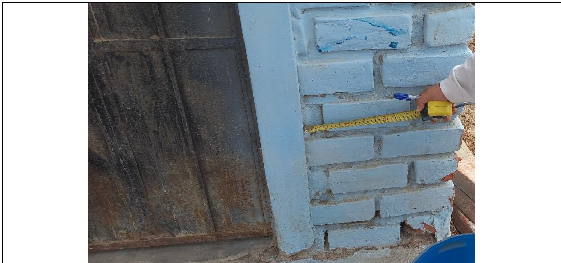
Figura 42. Muro de ladrillo de módulo 5
