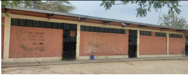
Figura 30. Fachada del módulo 2
