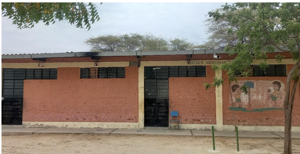
Figura 49. Suelo en módulo 2
