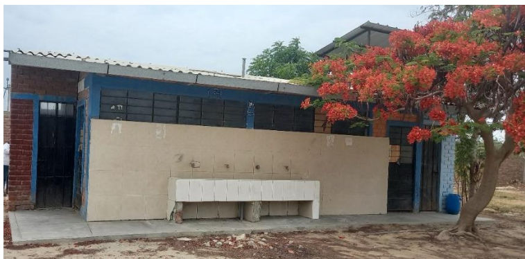
Figura 36. Fachada del módulo 5
