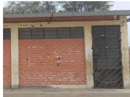
Figura 33. Puerta de ingreso del módulo 3
