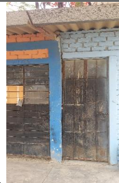
Figura 37. Puerta de ingreso del módulo 5
