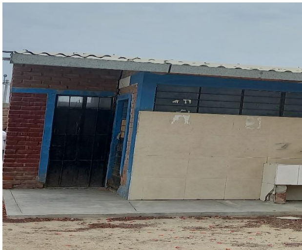
Figura 57. Conexión Muro-Techo en módulo 5
