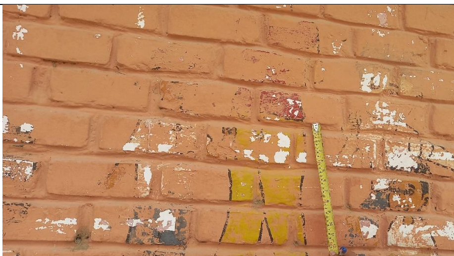
Figura 40. Muro de ladrillo del módulo 3
