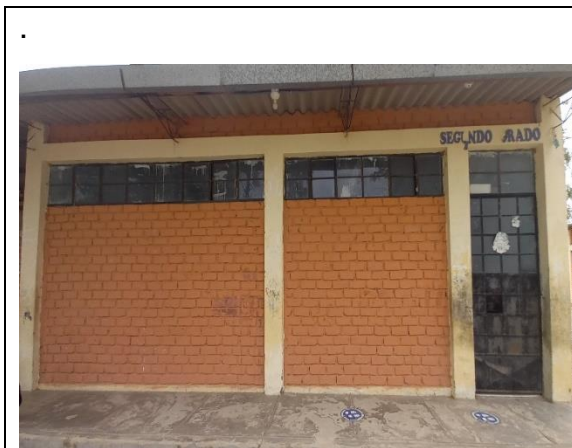
Figura 28. Fachada de módulo 1
