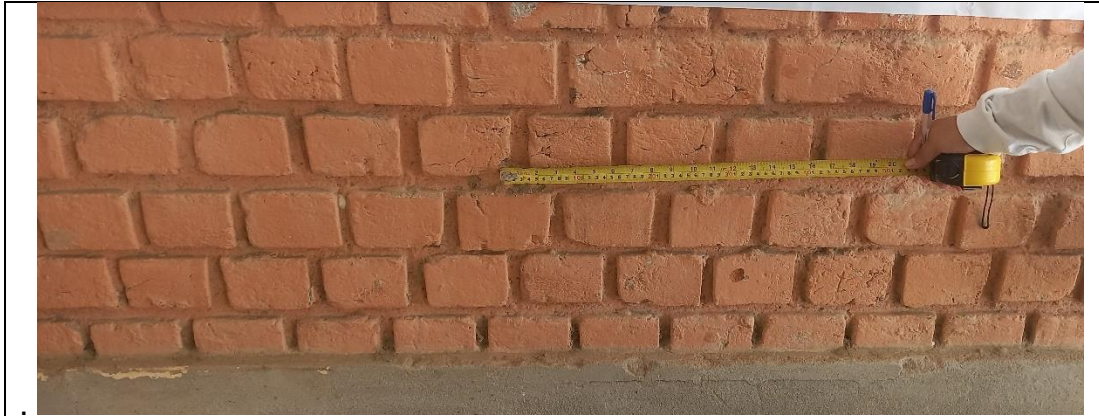
Figura 41. Muro de ladrillo del módulo 4
