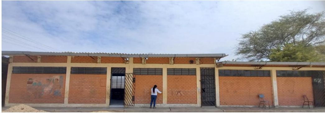
Figura 34. Fachada de módulo 4
