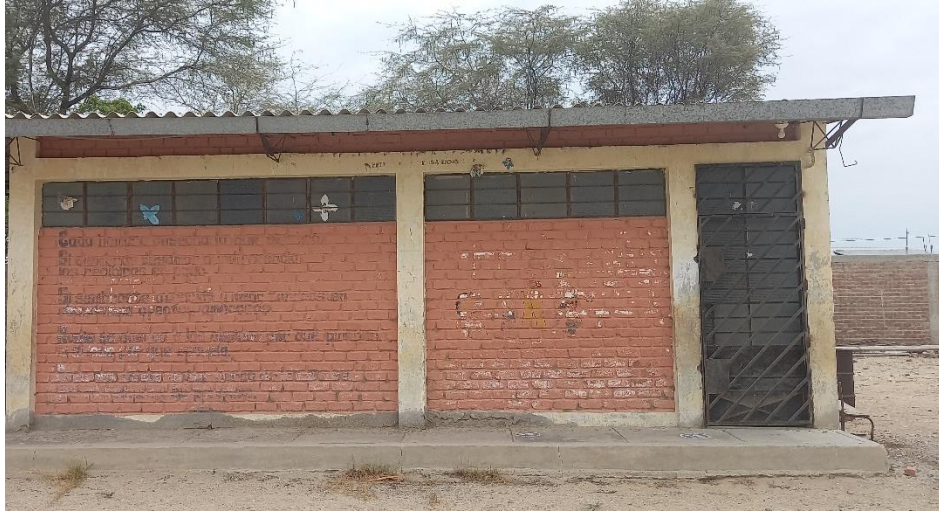
Figura 50. Suelo en módulo 3
