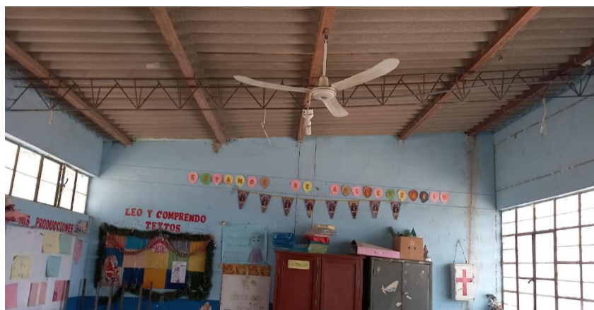
Figura 53. Conexión muro -techo en módulo 1
