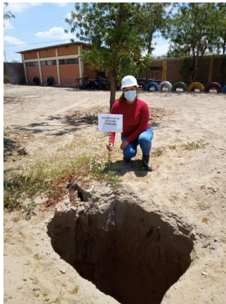
Figura 4. Excavación de calicata N° 2
