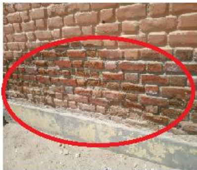
Figura 21. Disgregación de sobre cimiento en módulo 3
