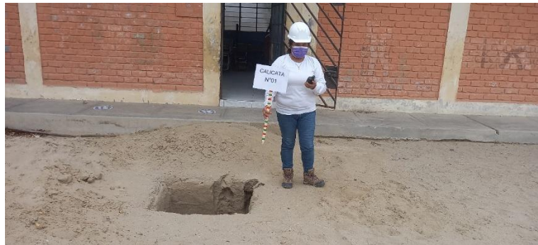
Figura 3. Excavación de calicata 1 en I.E 14120 Chapairá
