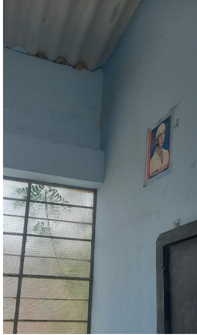
Figura 56. Conexión Muro-techo en módulo 4
