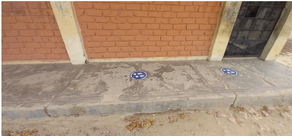
Figura 48. Suelo en módulo 1
