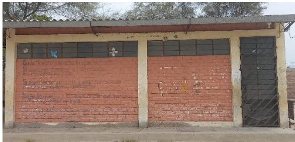
Figura 32. Fachada del módulo 3
