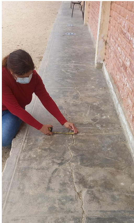
Figura 51. Suelo en módulo 4
