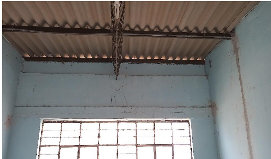
Figura 55. Conexión Muro-Techo en módulo 3
