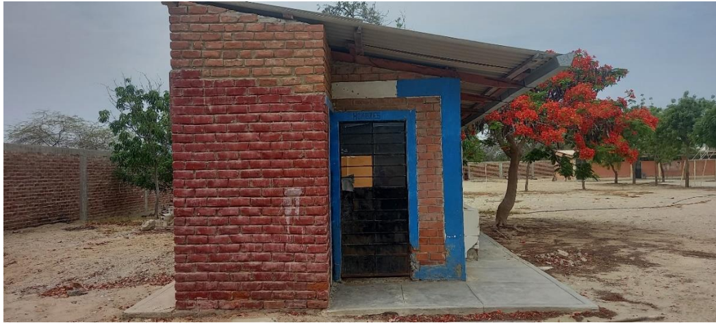
Figura 52. Suelo en módulo 5
