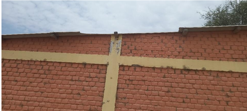
Figura 64. Cubierta en módulo 3
