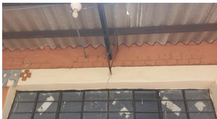
Figura 63. Cubierta en módulo 2
